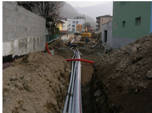
Figura 55 - Connessione tra i pozzi di emungimento 2
