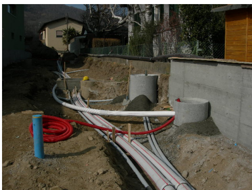
Figura 58 - Connessione tra i pozzi di emungimento 7
