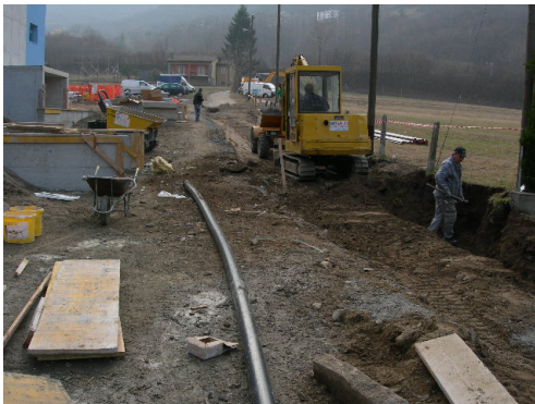
Figura 54 - Connessione tra i pozzi di emungimento 1
