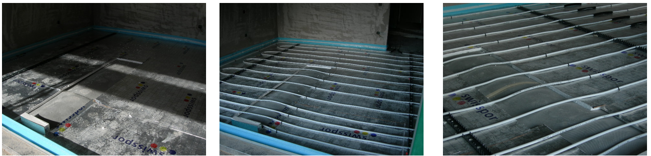
Figura 43 - Solaio 3, fase di costruzione 5
