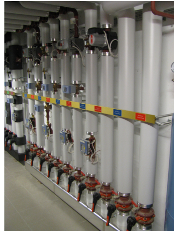
Figura 67 - Collettore caldo di distribuzione
