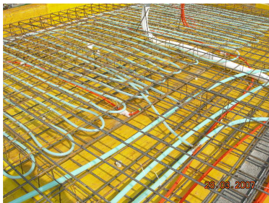
Figura 35 – Solaio 1, fase di costruzione 3
