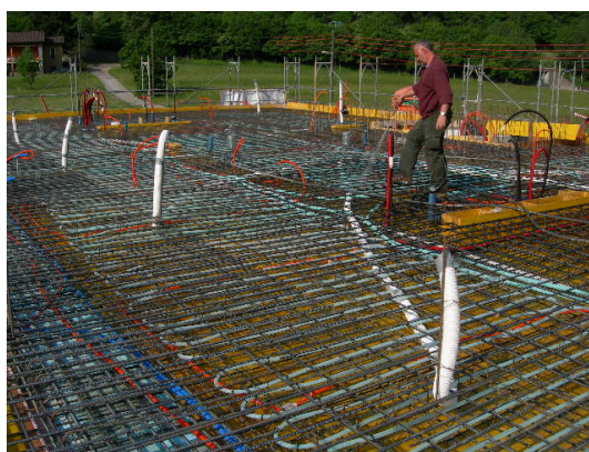
Figura 37 – Solaio 1, fase di costruzione 5
