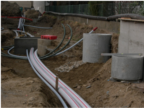
Figura 48 - Posizionamento tubazioni orizzontali 3
