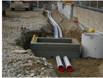
Figura 47 - Posizionamento tubazioni orizzontali 2
