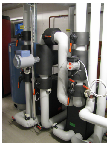
Figura 60 - Scambiatori a piastre 1
