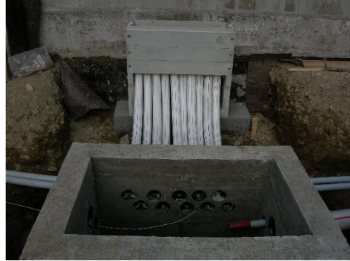
Figura 53 - Collegamento tra il pozzo e la centrale termica 2
