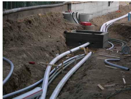
Figura 49 - Posizionamento tubazioni orizzontali 4
