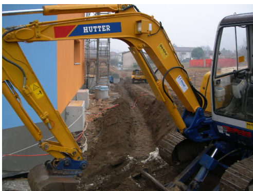
Figura 44 - Esecuzione dello scavo
