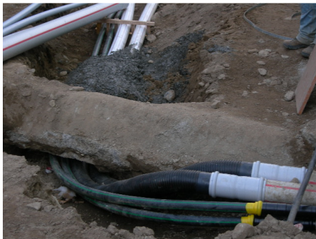
Figura 48 - Posizionamento tubazioni orizzontali 3
