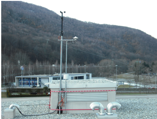
Figura 72 - Stazione meteorologica posta sul tetto
