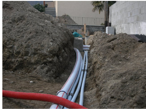
Figura 49 - Posizionamento tubazioni orizzontali 4
