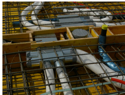
Figura 34 – Solaiio 1, fase di costruzione 2
