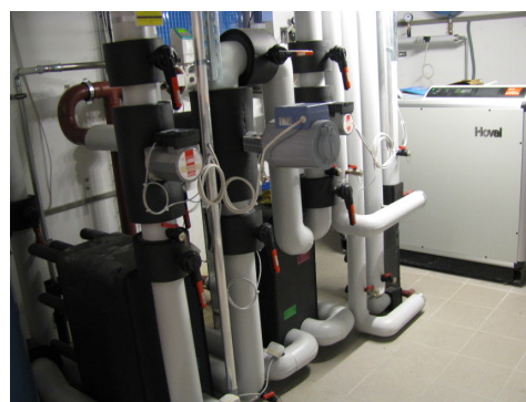
Figura 61 - Scambiatori a piastre 2
