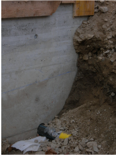
Figura 52 - Collegamento tra il pozzo e la centrale termica 1
