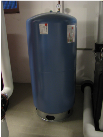
Figura 64 - Vaso d'espansione
