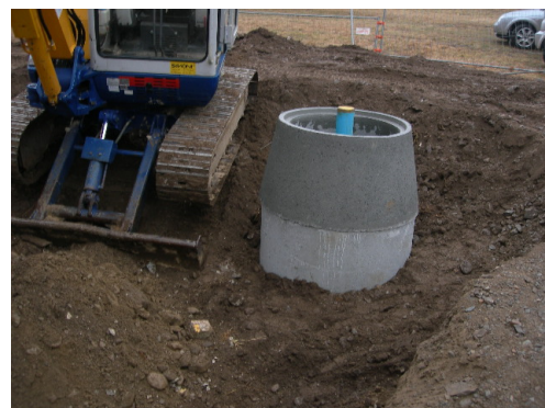
Figura 45 – Posizionamento del pozzo
