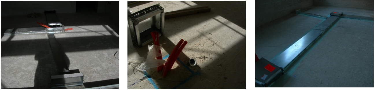
Figura 42 - Solaio 3, fase di costruzione 4
