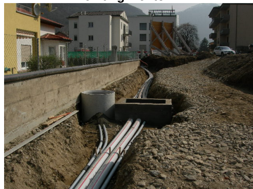
Figura 55 - Connessione tra i pozzi di emungimento 2
