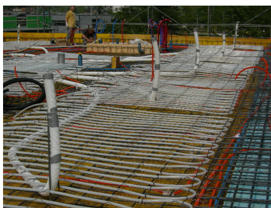
Figura 36 – Solaio 1, fase di costruzione 4
