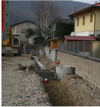
Figura 46 - Posizionamento tubazioni orizzontali 1
