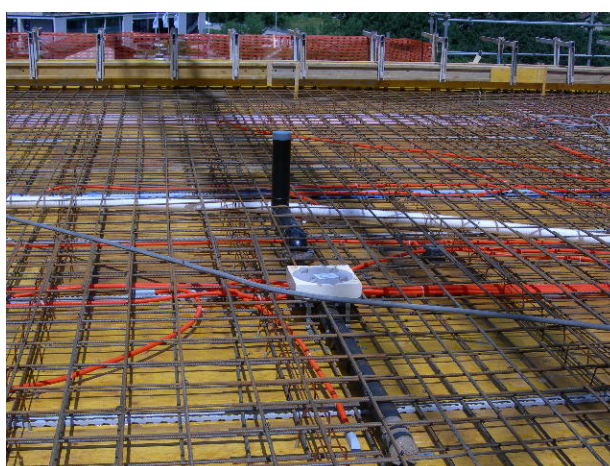
Figura 40 - Solaio 3, fase di costruzione 2
