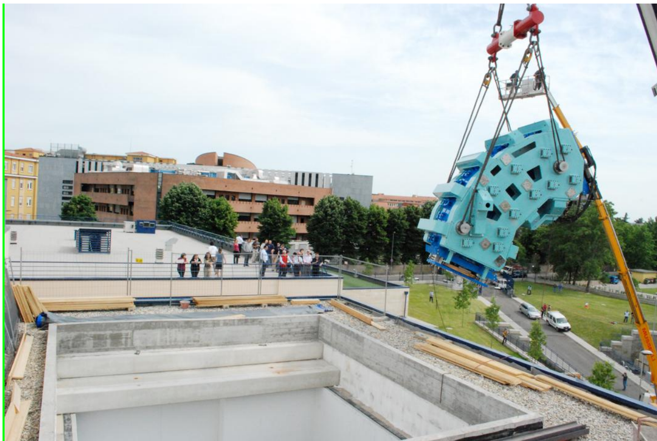
Figura 10: La fase di avvicinamento del magnete all'apertura nel soffitto della sala centrale
