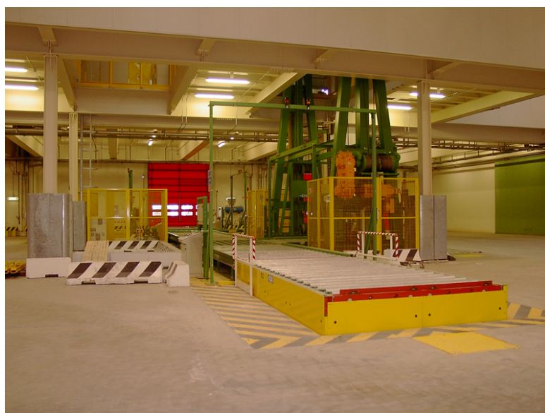
Figura 5.5: Isola di lavorazione, visione complessiva
