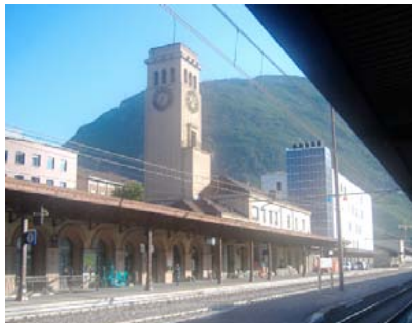
Fig.62 Il fabbricato viaggiatori.
