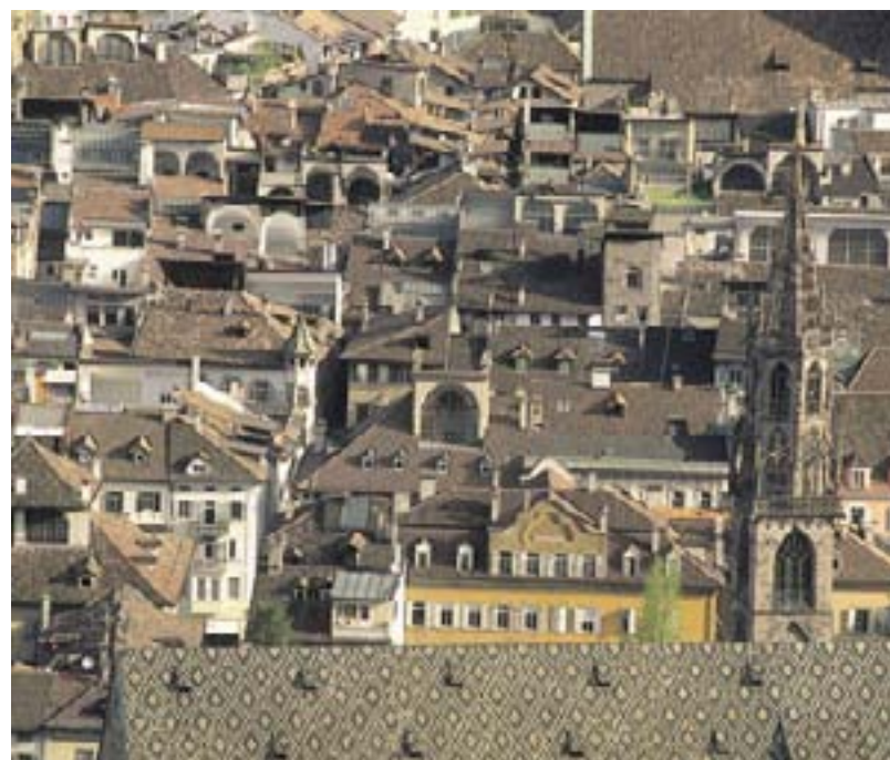
Fig.78 Il Centro Storico.
