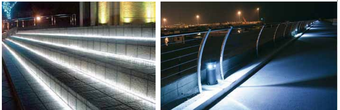
Gruppo figure 44: Sistemi di illuminazione LED per esterni
