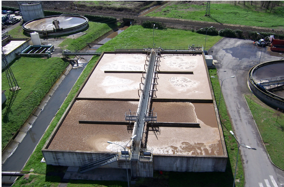
FOTO 5: Comparti linea B per ossidazione biologica/nitrificazione
