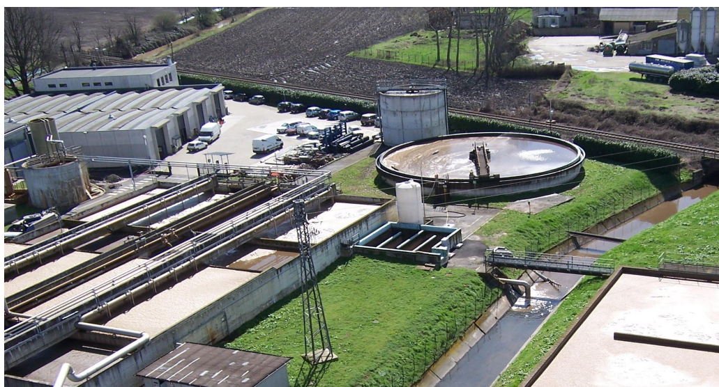
FOTO 6: Sedimentatore linea A
