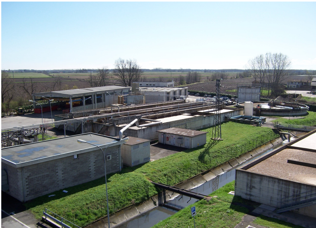
FOTO 2: Impianto di depurazione di Mortara
