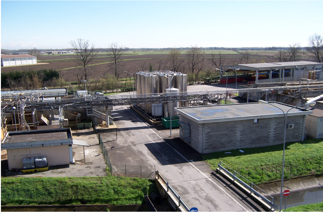
FOTO 1: Impianto di depurazione di Mortara
