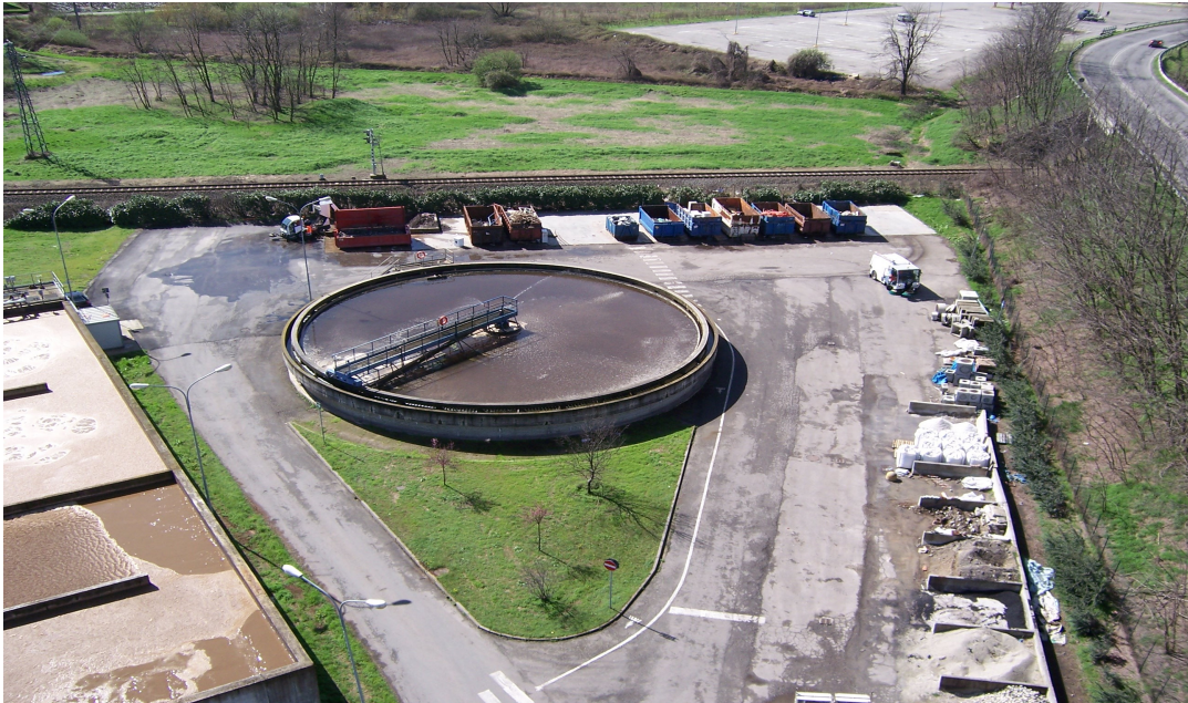
FOTO 7: Sedimentatore linea B
