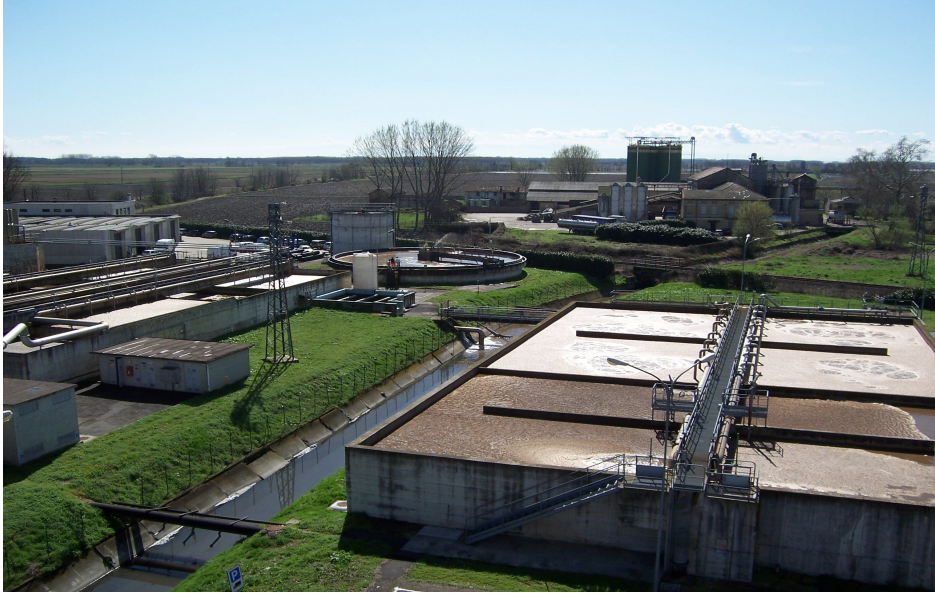
FOTO 3: Impianto di depurazione di Mortara
