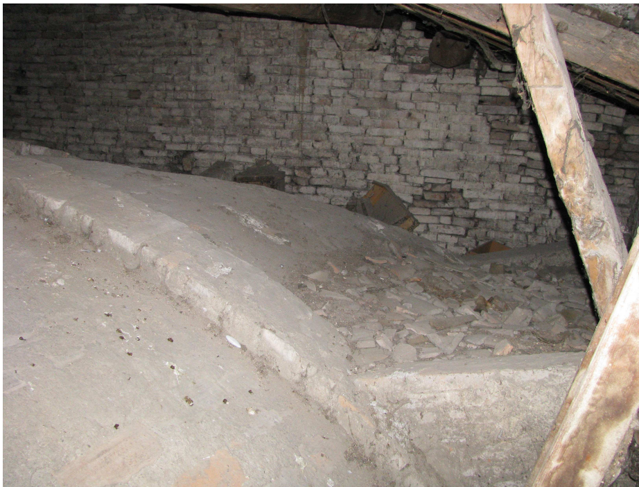
Figura 4.9: particolare dei costoloni mediani sul lato corto della volta a padiglione. (luglio 2010)
