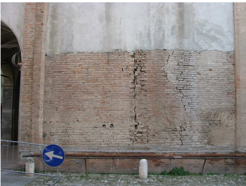
Figura 4.17: Particolare della muratura del prospetto settentrionale della chiesa. Si noti l'arco di scarico e l'attacco fra l'antica muratura della chiesa e quella tardo quattrocentesca del muro del sottoportico.
