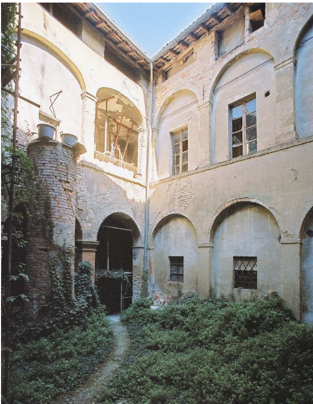
Figura 1.12: veduta della corte interna dell'ospitale.
