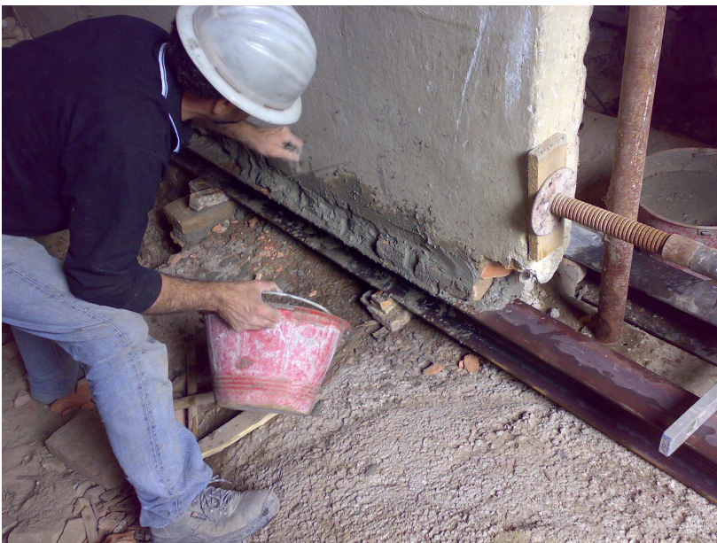
Figura 4.5: Posizionamento del doppio profilato metallico rinforzo della trave portamuro. (Gennaio 2009)
