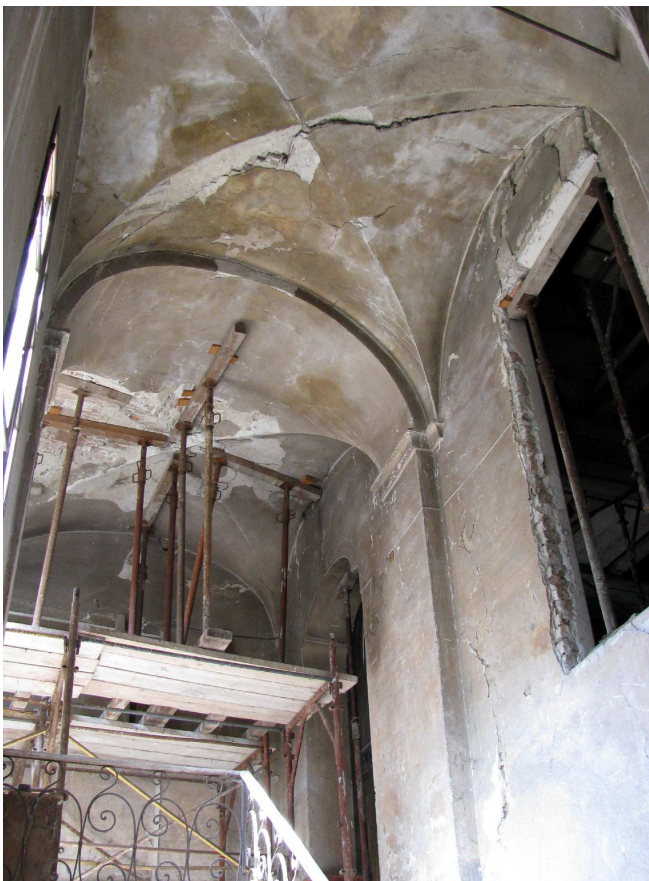
Figura 4.7: pericolosa lesione della seconda crociera del vano scala. (marzo 2010)
