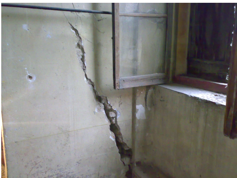
Figura 4.3: lesione originata dal ribaltamento verso l'esterno del prospetto dell'ospitale.
