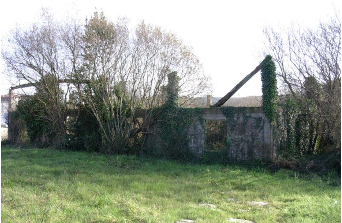
Foto 5. Aserradero en ruinas en la zona degradada 1.
