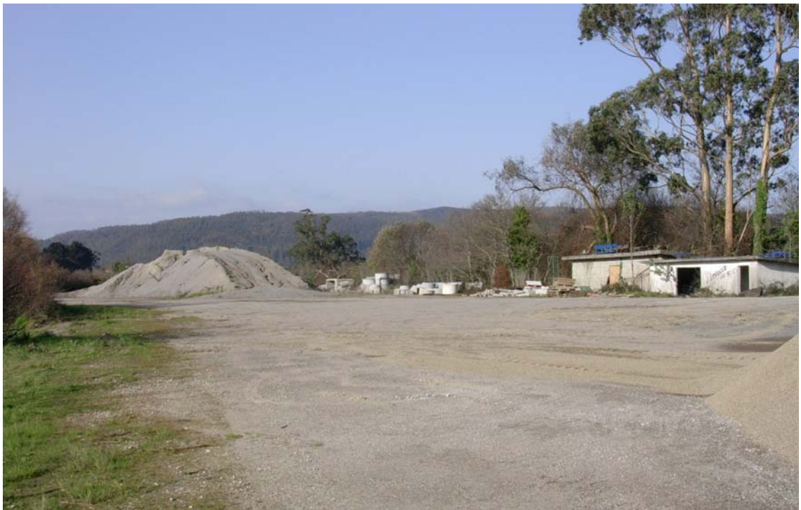
Foto 21. Explanada creada para el aprovechamiento de la cantera y caseto de obra a demoler.
