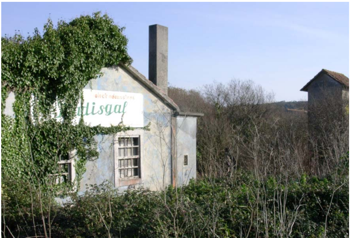
Foto 6. Casa y caseto de la luz abandonados.
