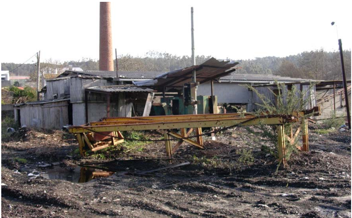
Foto 13. Zona degradada 2. Antiguo aserradero abandonado.
