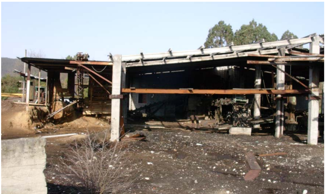
Foto 14. Acceso totalmente libre a las instalaciones del antiguo aserradero.
