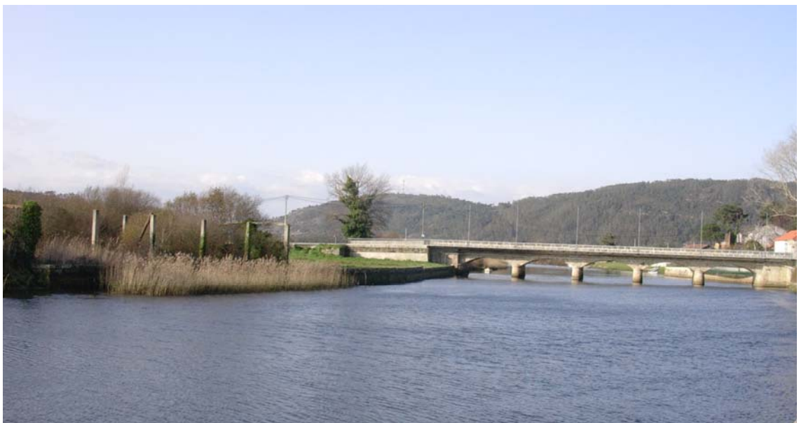
Foto 4. Vista general del puente y de la zona degradada 1.
