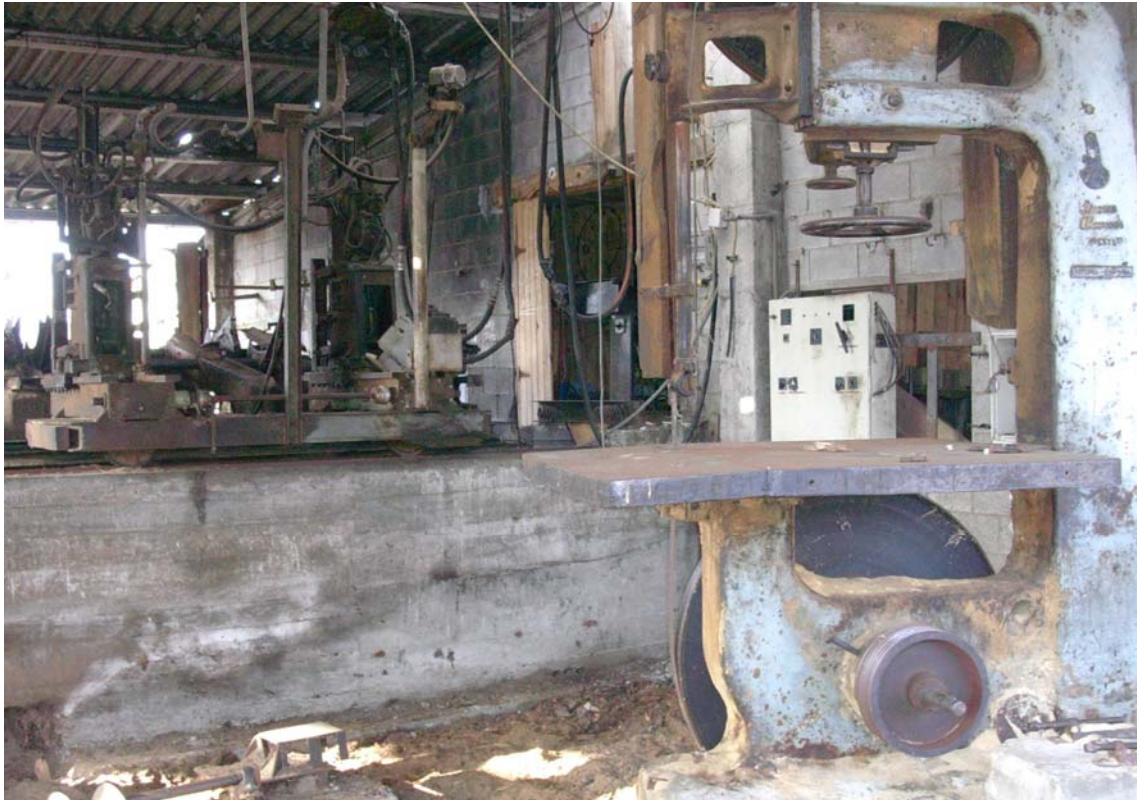
Foto 15. Maquinaria abandonada al aire libre del aserradero.
