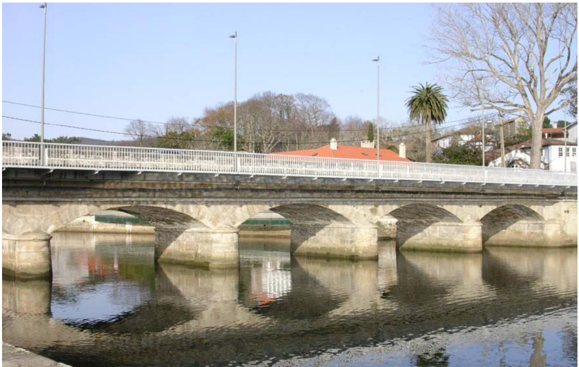
Foto 2. Puente de Ponteceso visto desde aguas arriba.
