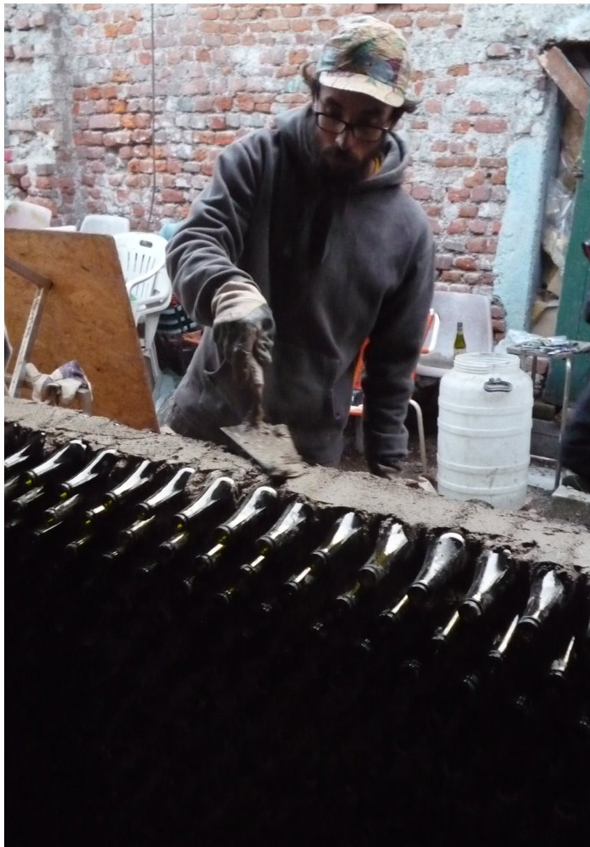
Illustrazione 60: autocostruzione di una parete di bottiglie in Cascina Torchiera.
