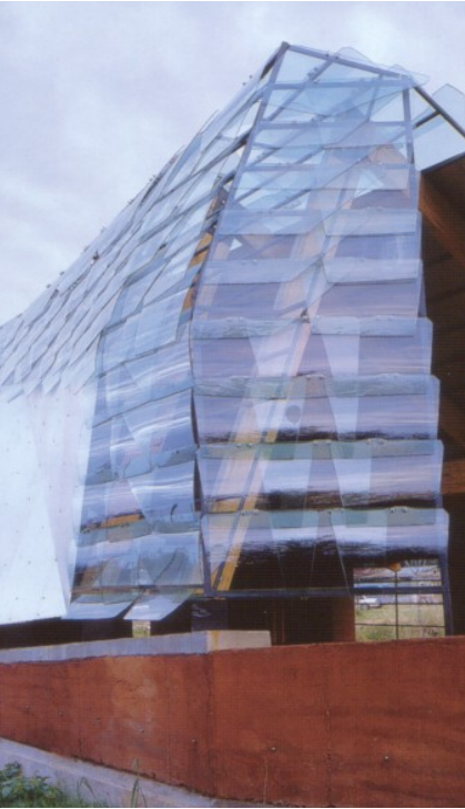
Illustrazione 74: Rural Studio, Glass Chapel, Mason's Bend, AL, U.S.A. (2000). La facciata nord è realizzata con finestrini recuperati.
