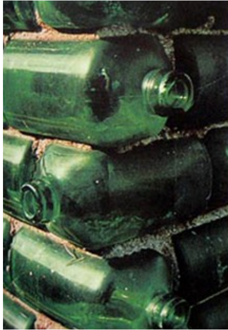
Illustrazione 59: dettaglio connessione angolo.
