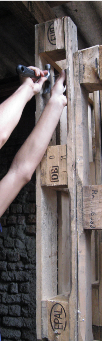
Illustrazione 20: autocostruzione di una parete in bancali di legno.
