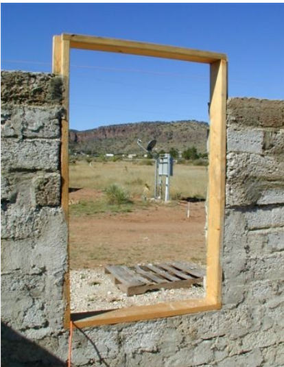
Illustrazione 45: realizzazione di un'apertura in una parete di blocchi in papercrete.
