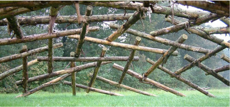
Illustrazione 54: struttura reciproca con 90 pali di legno, costruita da Rinus Roelofs (Olanda, 2001).
