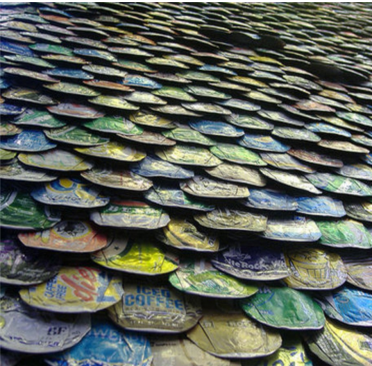
Illustrazione 77: rivestimento in lattine pressate.
