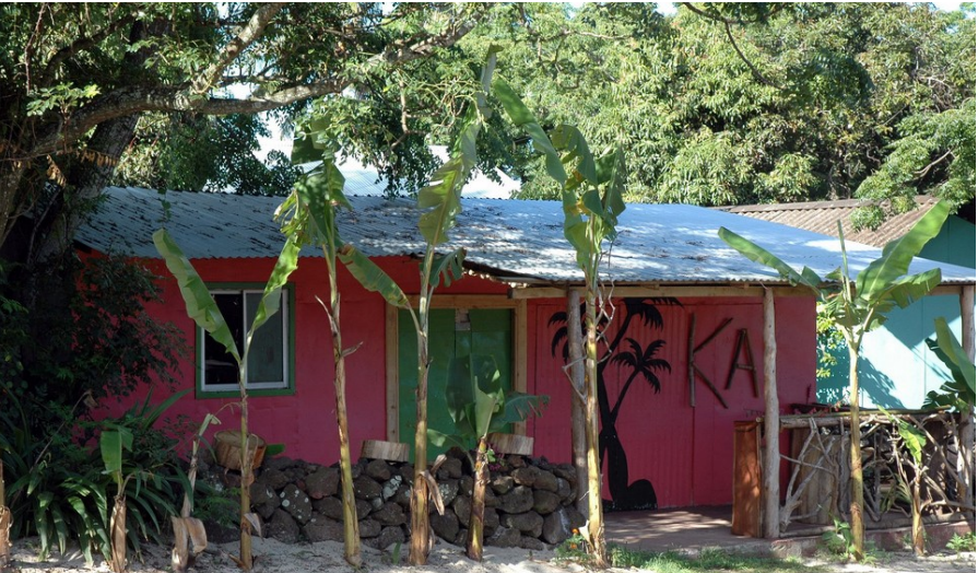
Illustrazione 8: abitazione a Hanga Roa, realizzata con lamiera recuperata.
