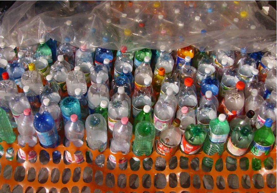
Illustrazione 62: parete di bottiglie, prototipo Wo.Bo. 2.0, fase di montaggio
