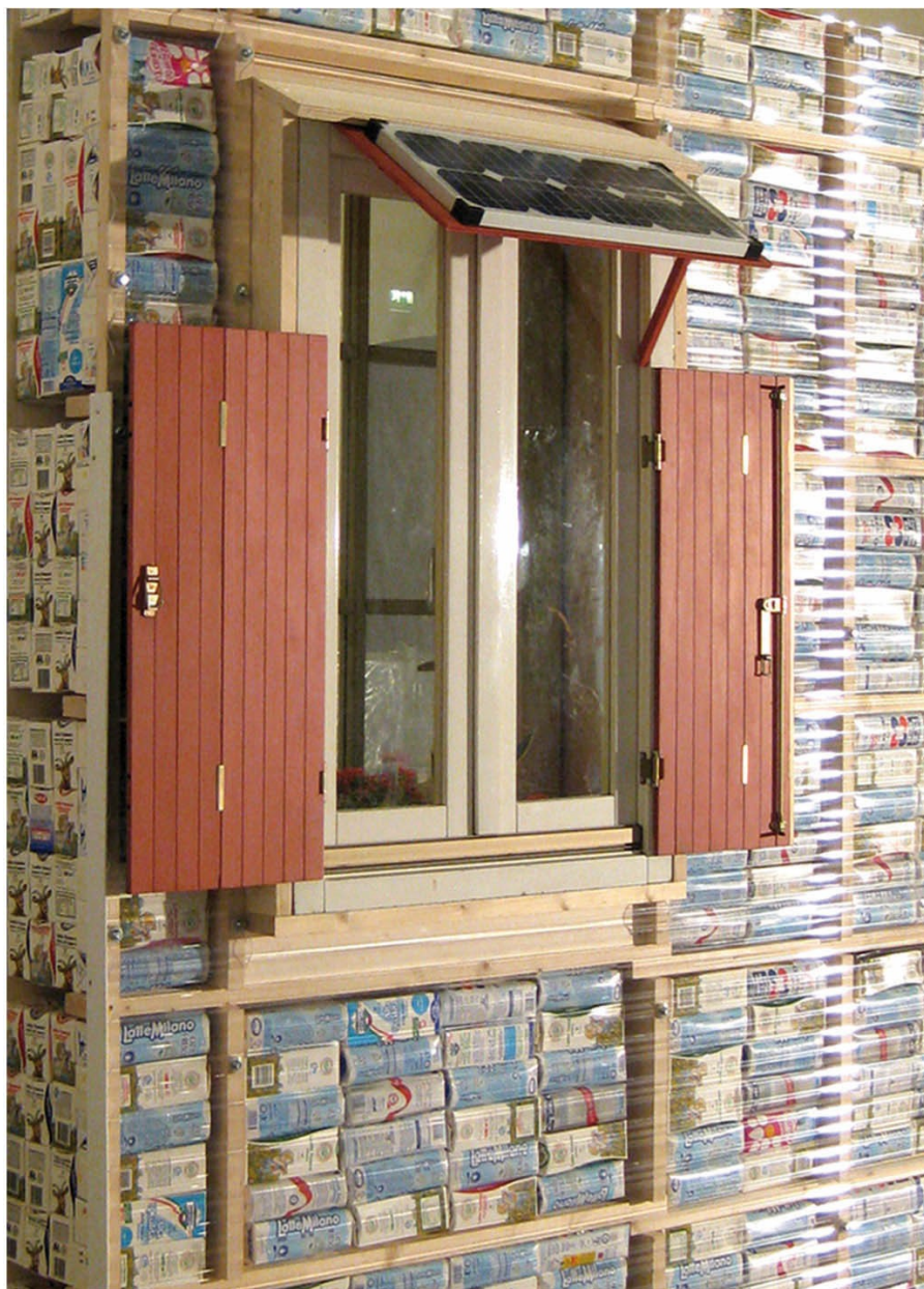
Illustrazione 65: prototipo parete in Tetra Pak presentato alla Biennale di Venezia (2008) da Albori.
