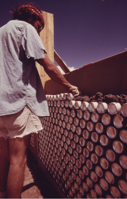
Illustrazione 56: autocostruttore che realizza una parete in lattine di metallo recuperate.
