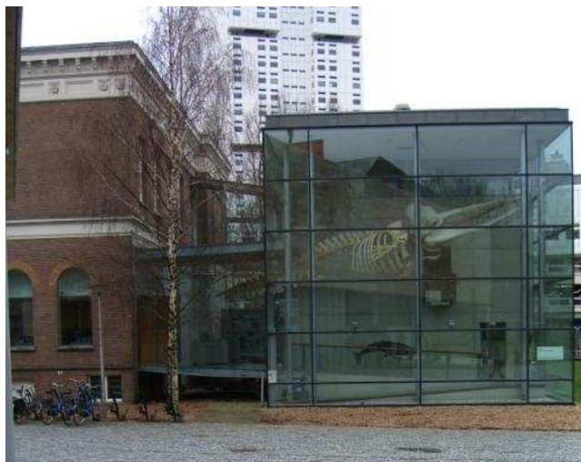
Fig.127 Vista esterna dell'edificio
