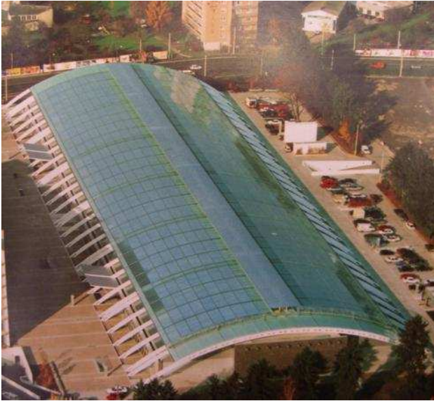
Fig.100 Vista dall'alto dell'edificio
