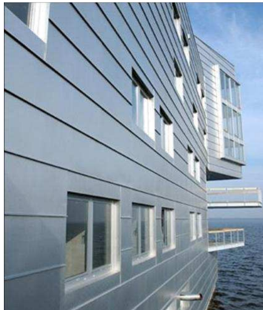
Fig. 190 Il rivestimento di facciata, in doghe metalliche orizzontali.
