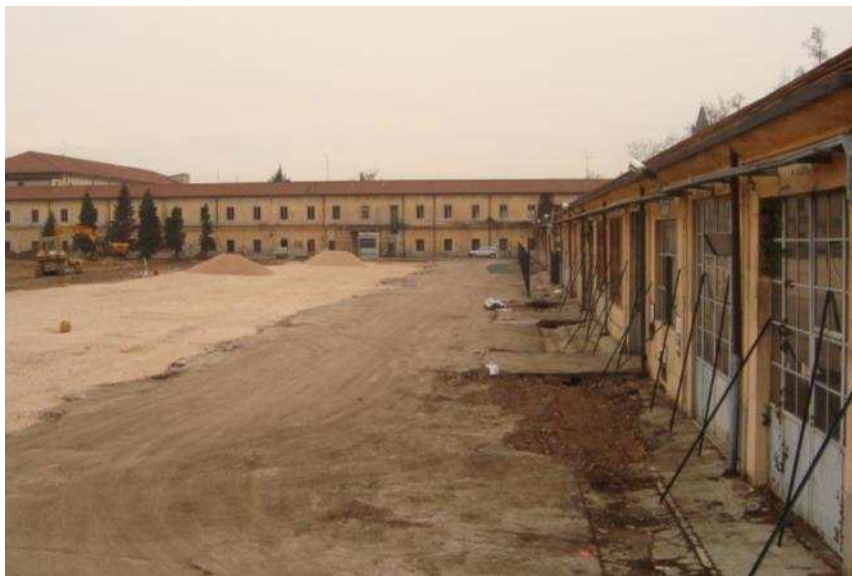
Fig. 149 Inquadramento dell'area durante i lavori per la realizzazione dei parcheggi.
