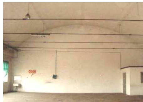
Fig. 71 L'ex edificio militare, visto dall'interno.
