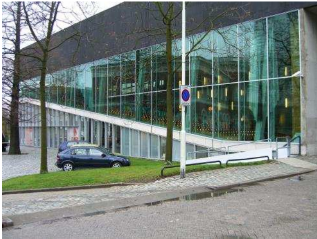
Fig.107 Vista del prospetto principale dell'edificio
