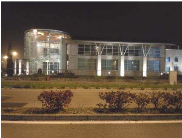
Fig.105 Vista di un prospetto principale dell'edificio
