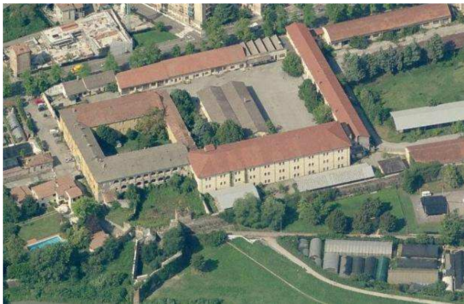
Fig. 31 Vista aerea della Caserma Riva di Villasanta.
