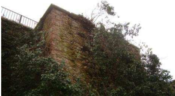
Fig. 66 Particolare della torre mozza.
