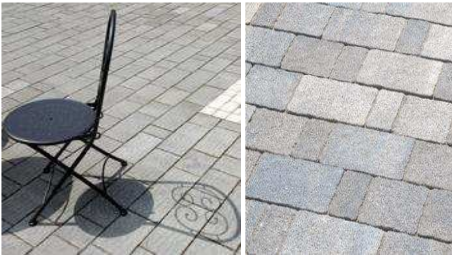
Fig. 193 Esempi applicativi di pavimentazione foto - catalitica in ambiente urbano.
