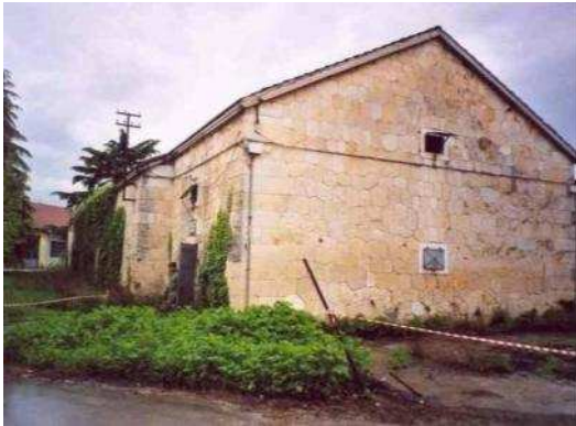
Fig. 47 Vista del lato nord
