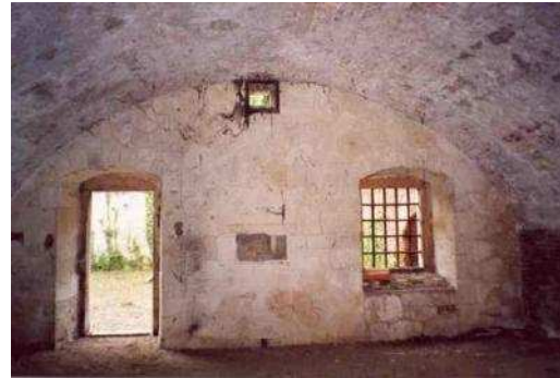
Fig. 43 Vista di un'arcata interna.
