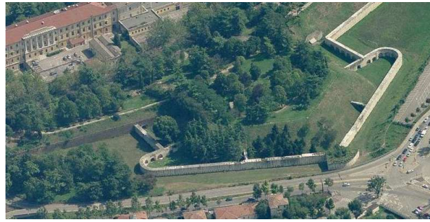
Fig. 14 Porta San Zeno e Bastione San Zeno, opere realizzate dal Sanmicheli nel sec. XVI, tuttora intatte.
