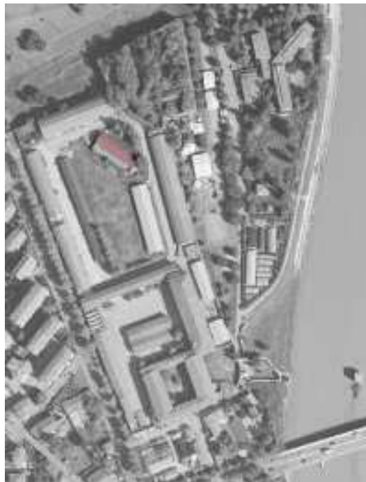
Fig. 44 Ortofoto dell'area oggetto di studio; in evidenza la Polveriera.
