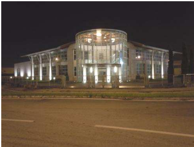
Fig.104 Vista dell'edificio: i due corpi lineari e il corpo cilindrico
