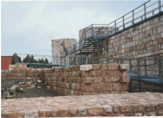
Fig.136 Vista del cammino di ronda realizzato in acciaio
