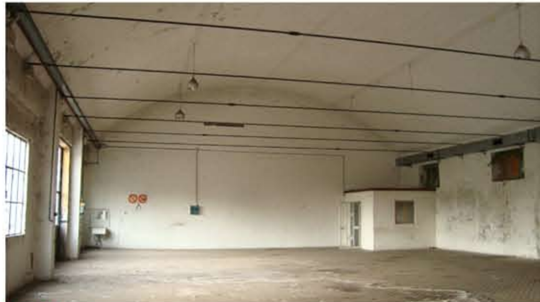
Vista 4 _ Gli spazi interni all'edificio
