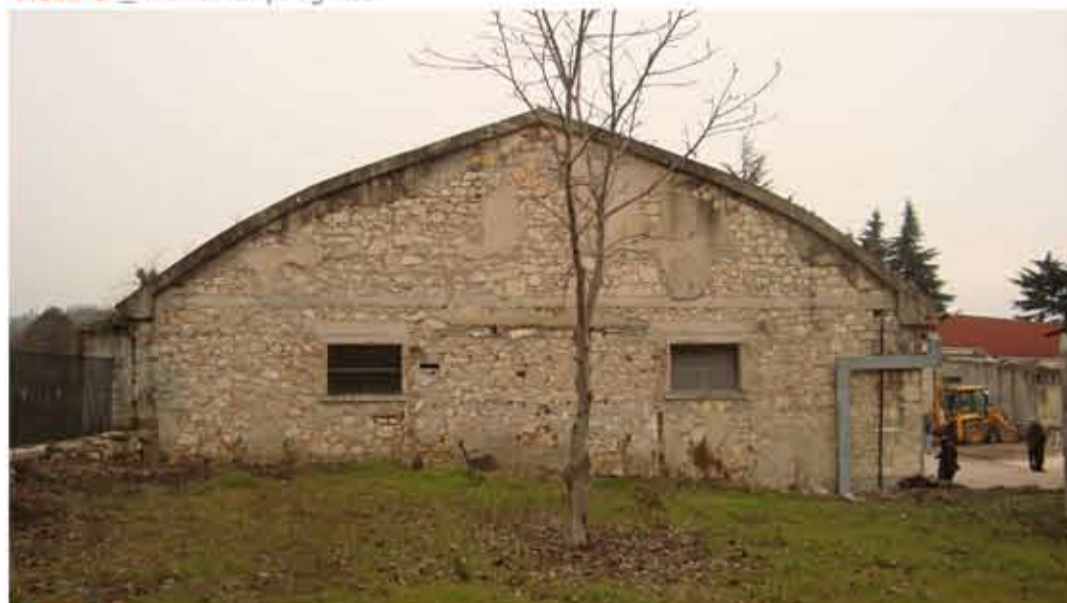
Vista 7 - Il prospetto ovest dell'ex edificio militare
