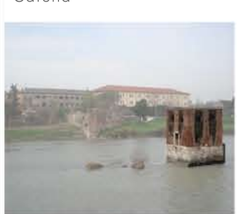
Torre fluviale della Catena Superiore nel Fiume Adige
