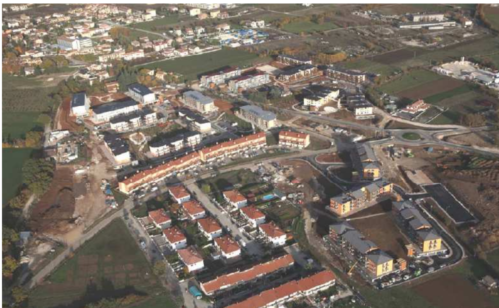
Figura 15, Vista aerea di un insediamento C.A.S.E.
