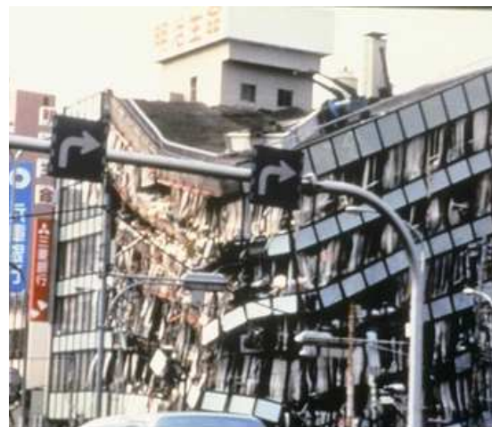
Figura 6 Effetti del terremoto
