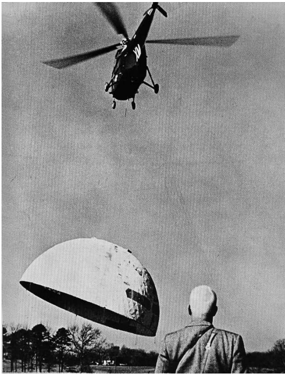
Figura 9, Cupola di B. Fuller aviotrasportata
