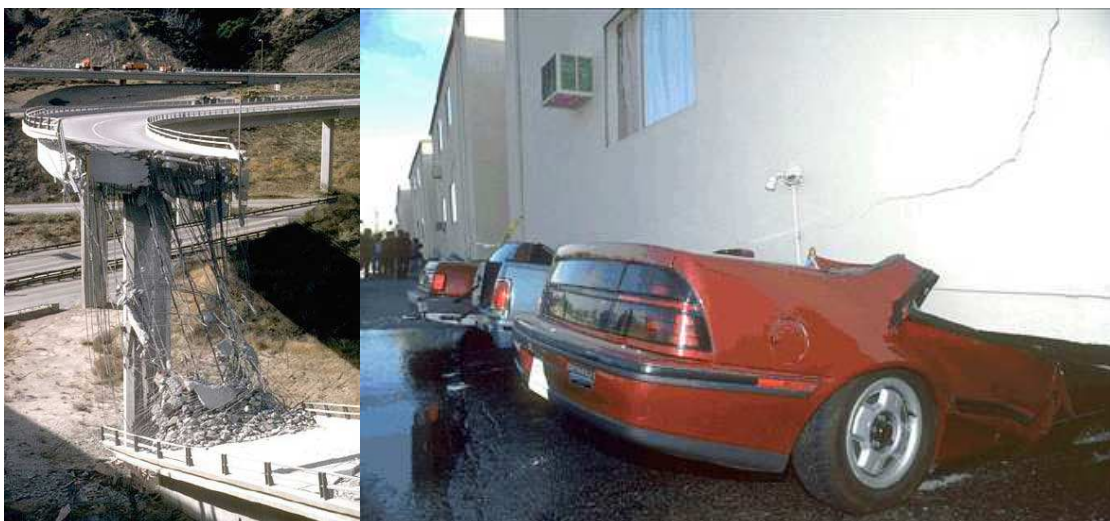
Figura 3 Effetti del terremoto Figura 4 Edifici crollati su se stessi
