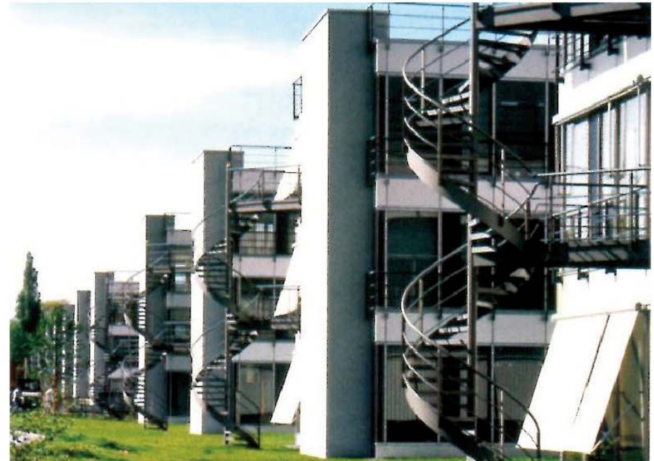
vista dei corpi trasversali, paralleli tra loro, orientati a nord
