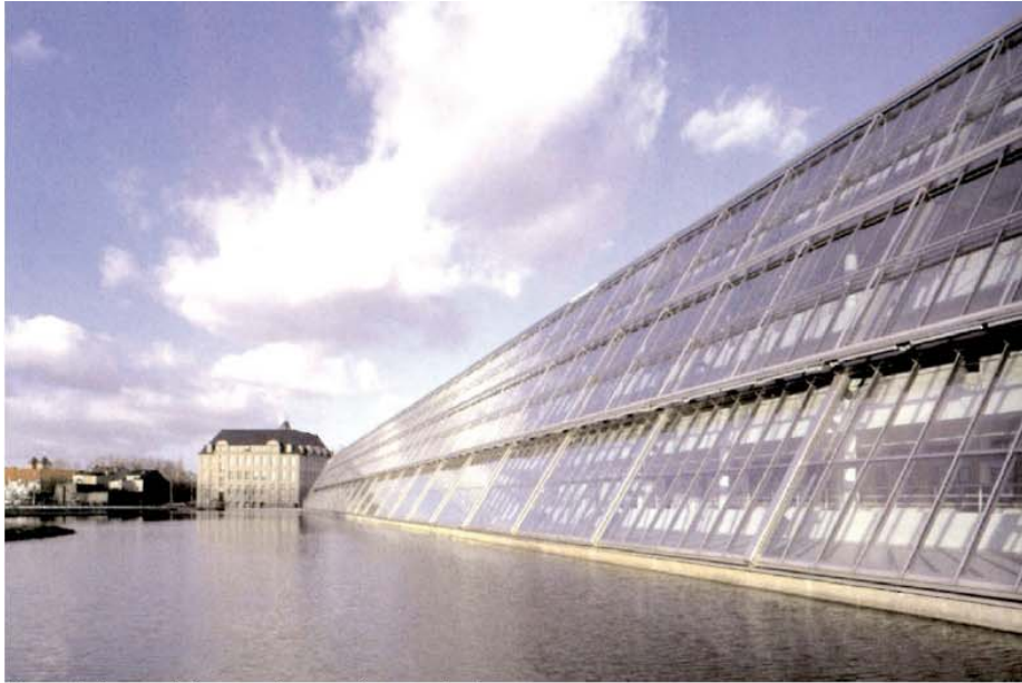
Facciata sud, in corrispondenza del corpo longitudinale, e il lago artificiale antistante
