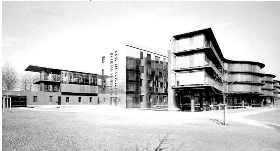
Vista laterale dei tre corpi di fabbrica
