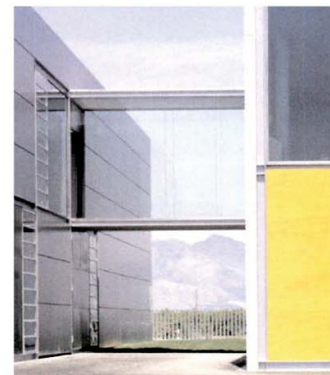
Uno dei collegamenti sopraelevati tra un edificio e l'altro
