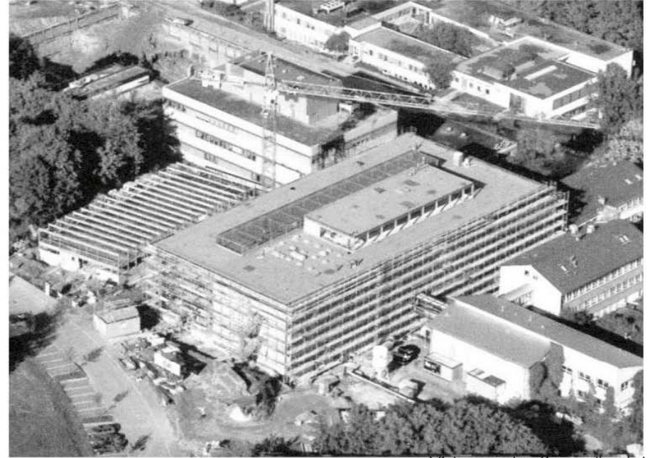
Vista a volo d'uccello del cantiere, a lavori praticamente ultimati
