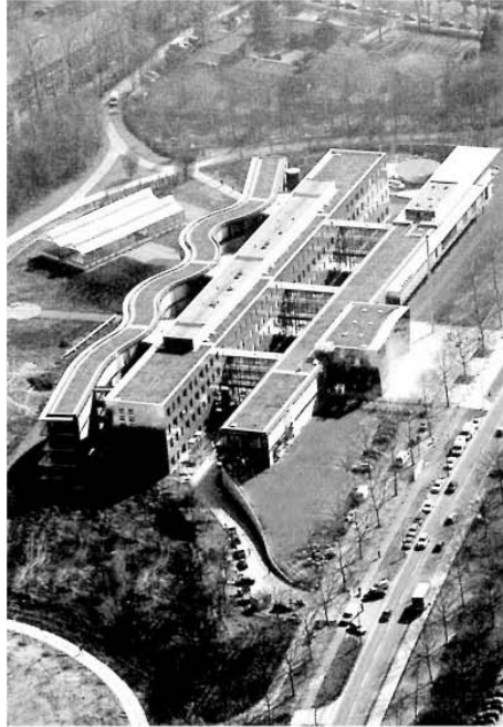
Vista a volo d'uccello del complesso
