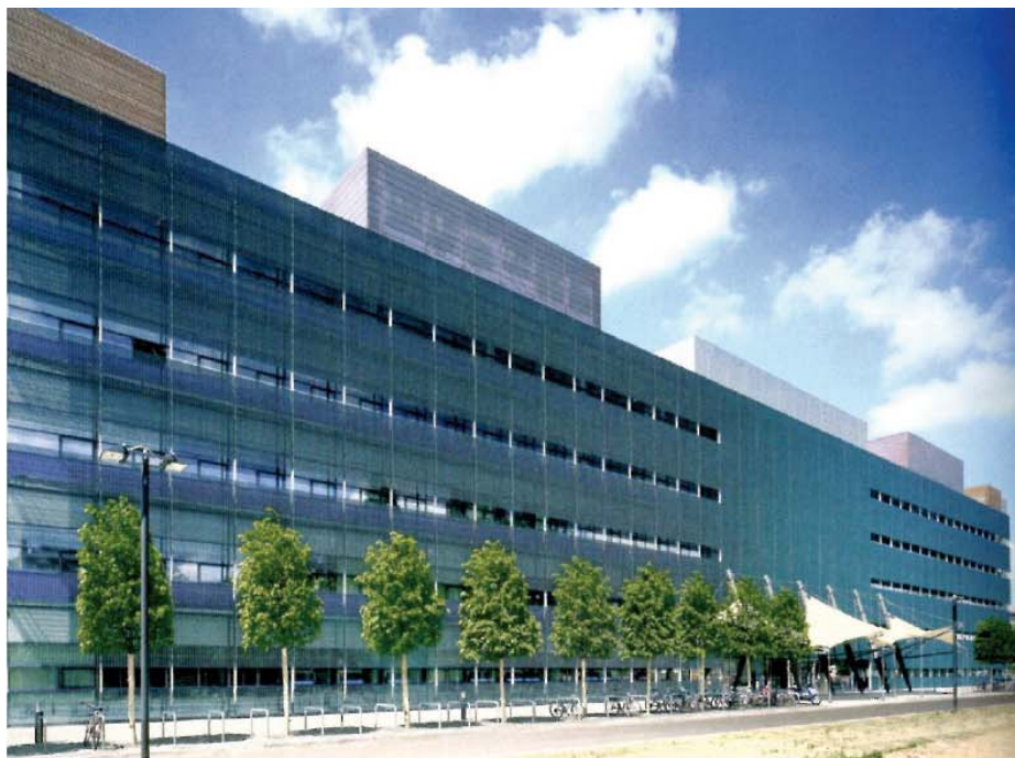
Vista della facciata principale
