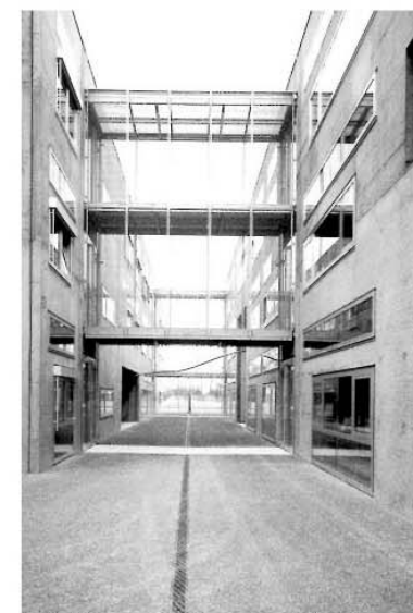
Collegamenti sospesi tra i corpi di fabbrica
