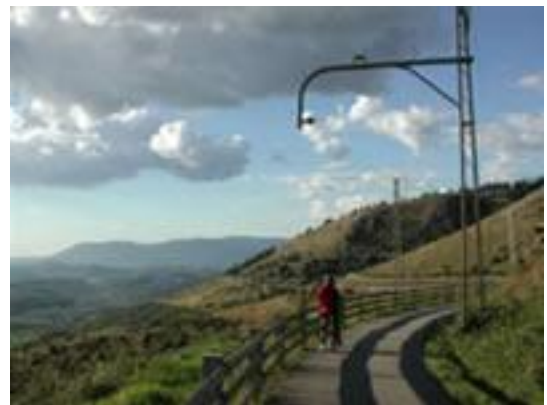
Figura n.26. Tratto del nuovo percorso verde.
