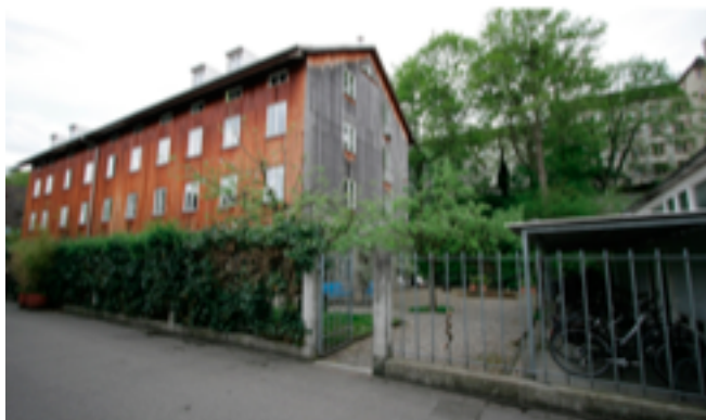
Fig. 17 - Basilea, architetto Michael Alder. Conversione di uno storico essiccatoio della carta in residenza.
