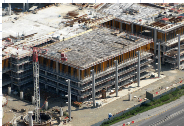
Figura 8 - Dettaglio della cassetatura
