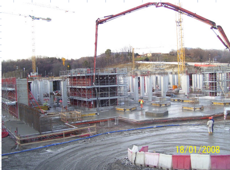
Figura 18 - Fase di getto della platea di fondazione
