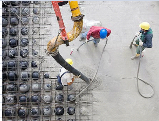
Figura 18 - Fase di getto di un solaio
