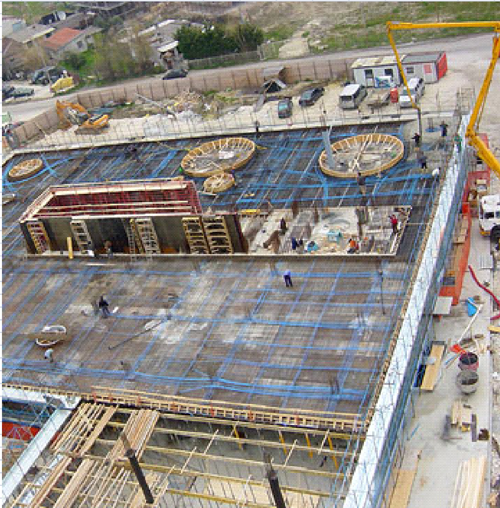
Figura 6 - Realizzazione prima soletta del corpo B
