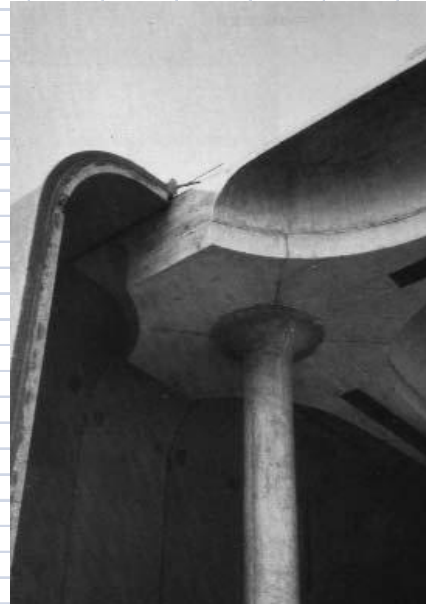
Figura 10 - Vista del particolare d'angolo della piastra
