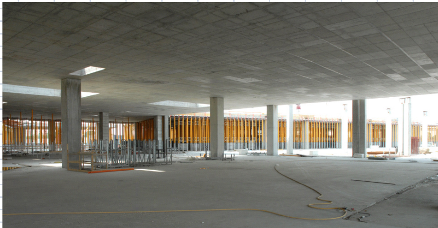
Figura 11 - Vista interna dopo il disarmo dell' impalcato
