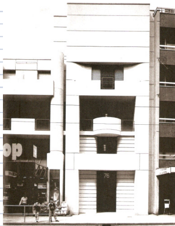
Figura 15 - Ingresso da Rue de Carouge
