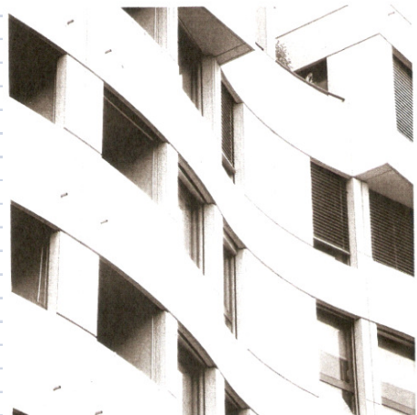
Figura 16 - Particolare facciata su Rue Dancet
