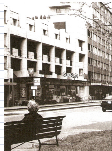
Figura 14 - Facciata su Rue de Carouge
