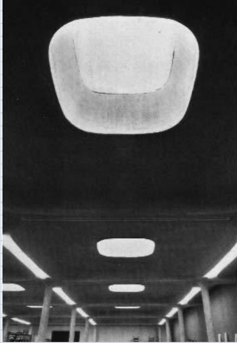
Figura 9 - Vista dei lucernari nelle piastre di copertura
