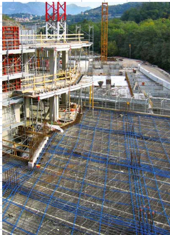
Figura 19 - Passaggio dei cavi post-tesi
