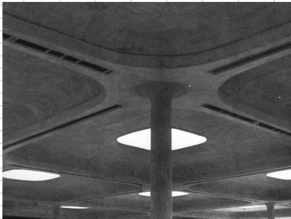
Figura 11 - Vista del particolare delle travi
