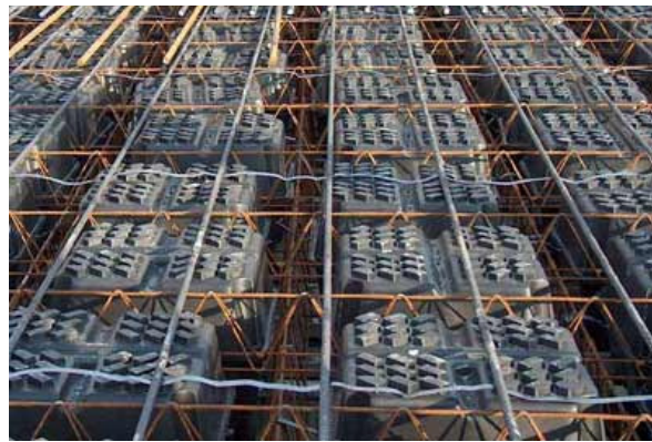
Figura 8 Particolare degli alleggerimenti poco prima dell'esecuzione del getto
