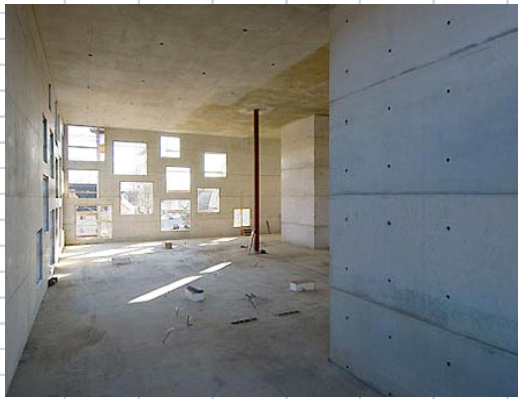
Figura 12 - Vista interna durante la costruzione
