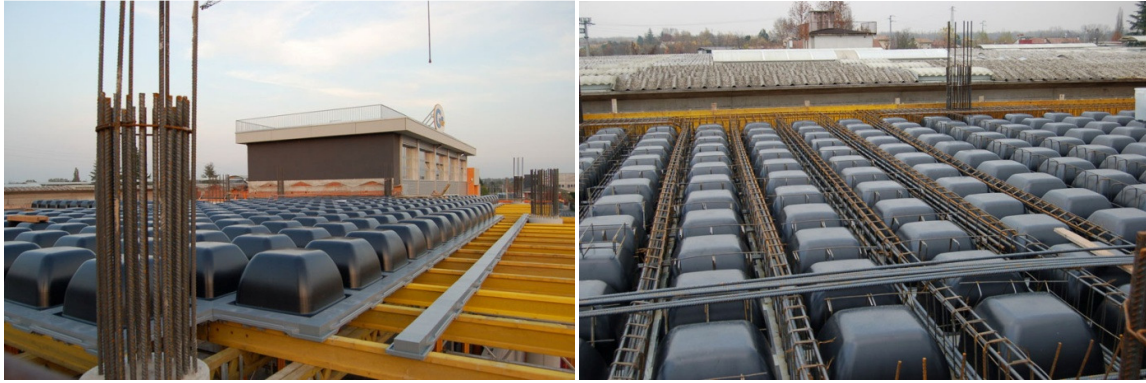
Figura 9 Posizionamento degli iglù (a sinistra). Armatura dell' impalcato (a destra)
