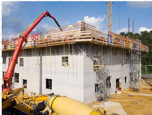
Figura 14 - Fasi di getto di un solaio
