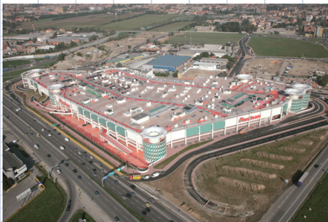
Figura 12 - Vista aerea complessiva
