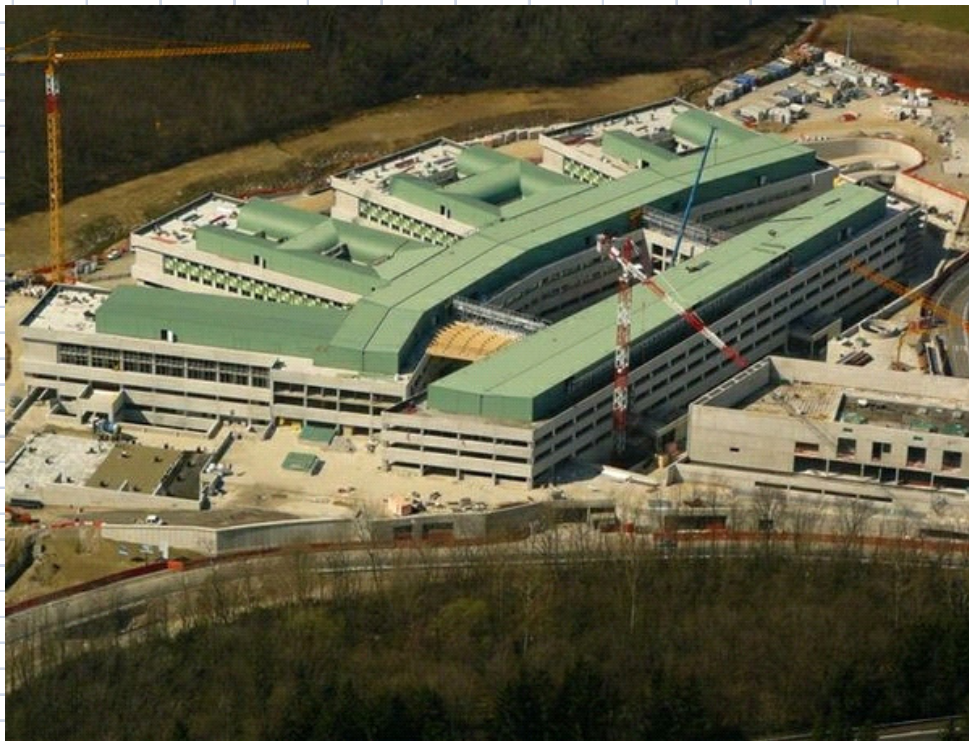
Figura 21 - Panoramica del cantiere nelle fasi finali
