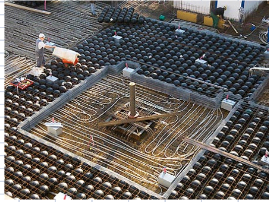
Figura 17 - Realizzazione di un solaio in corrispondenza di un pilastro
