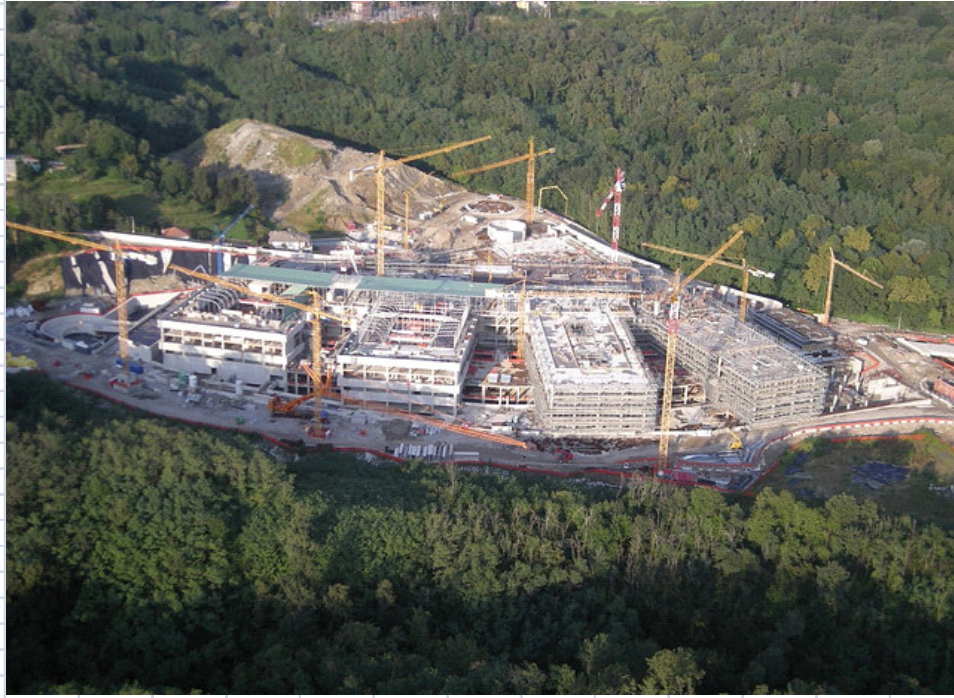
Figura 20 - Panoramica sullo stato di avanzamento dei lavori
