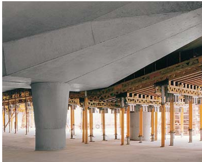
Figura 5 Parcheggio interrato – Fulda, Germania – 2005 (www.peri.it)
