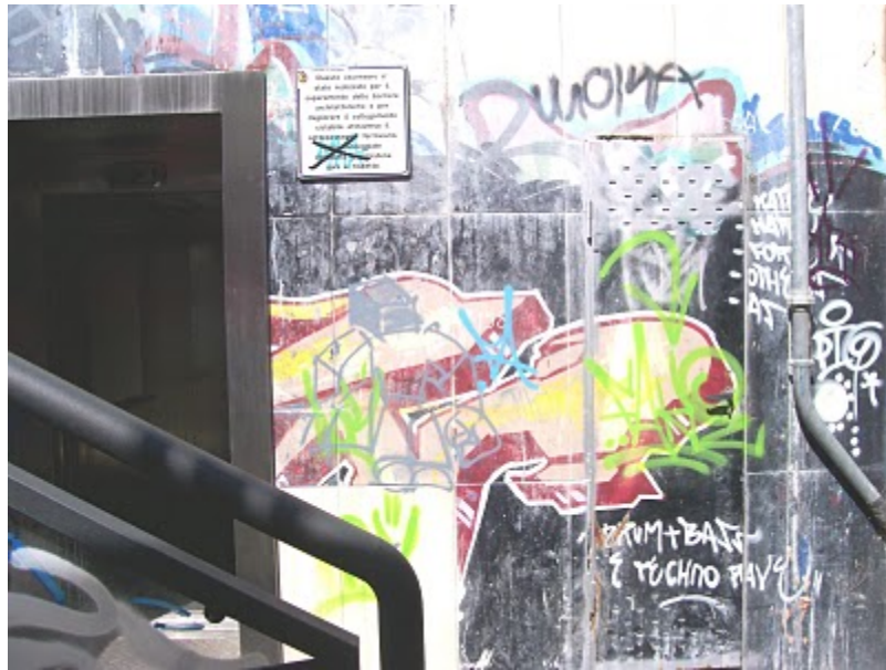
L'ingresso dell'ascensore al piano interrato
