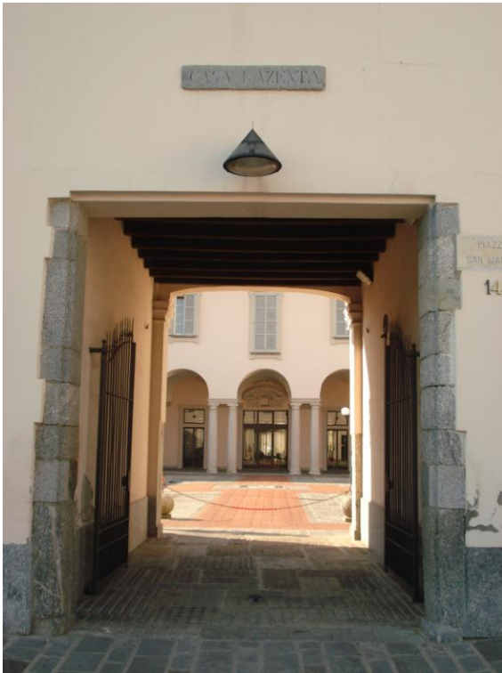
Ingresso principale Villa Mazenta
