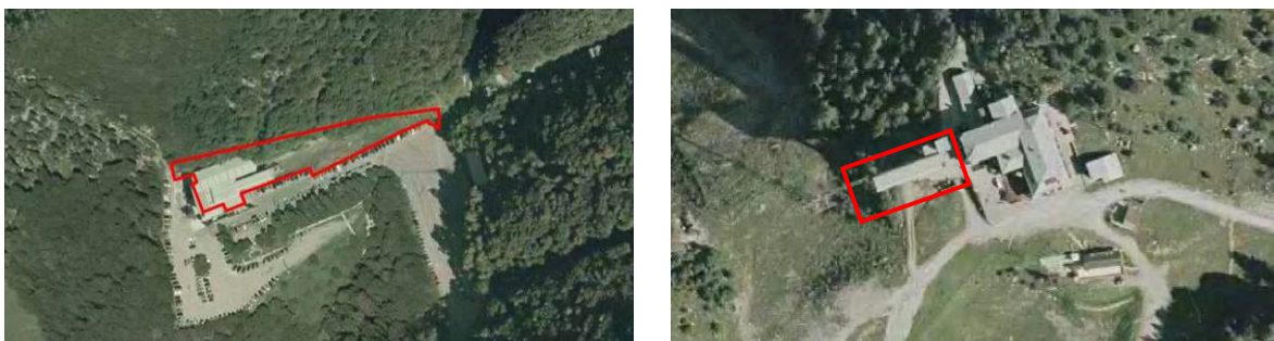
Fig. 93 - La stazione di valle (sinistra) e di monte (destra) dell'impianto di risalita Itb presso Barzio
