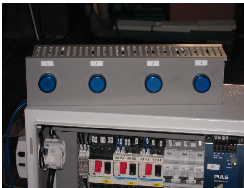
Figura 44: Lampadine per simulare la presenza pezzo
