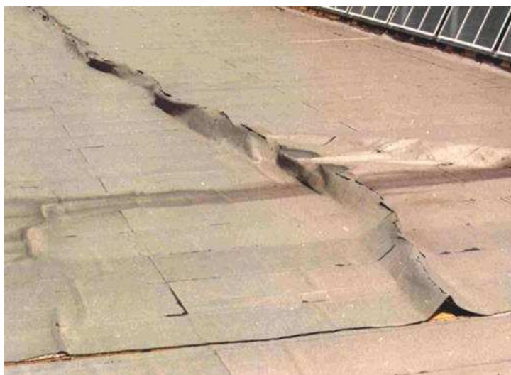
Figura 10: [CP 11] lesione per azione del vento
