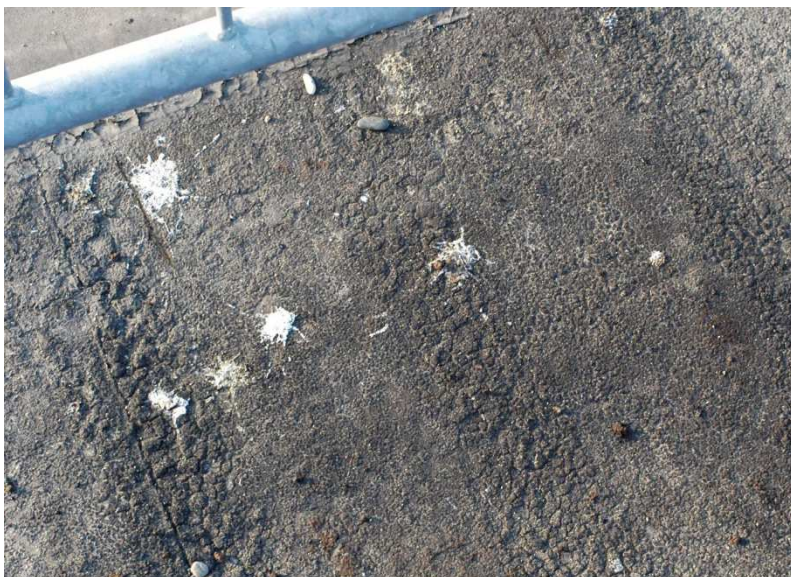
Figura 4: [CP 01] lesione membrana infragilita per invecchiamento
