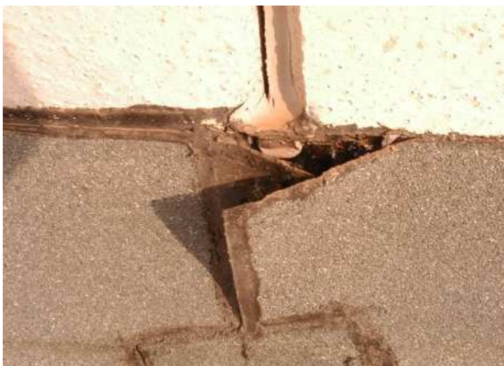
Figura 12: [CP 16] lesione per affaticamento
