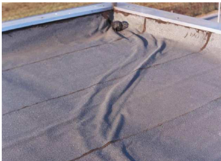
Figura 7: [CP 04] lesione da corrugamento
