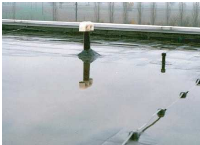
Figura 5: [CP 02] alterazione della membrana per agenti chimici
