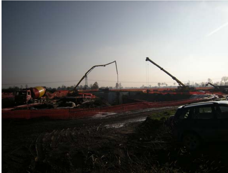
Figura 11 - Cantiere Brebemi a Castrezzato
