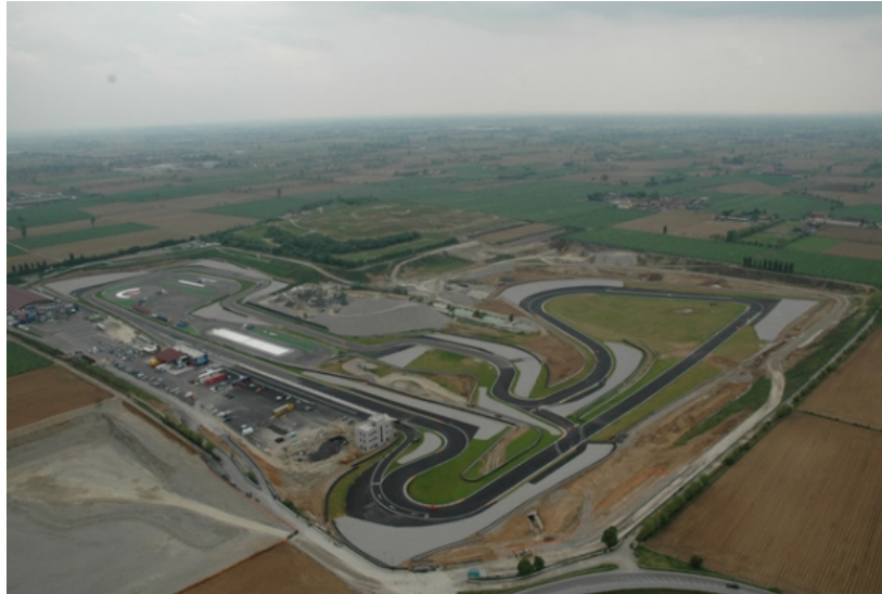
Figura 18 - Foto aerea dell'autodromo
