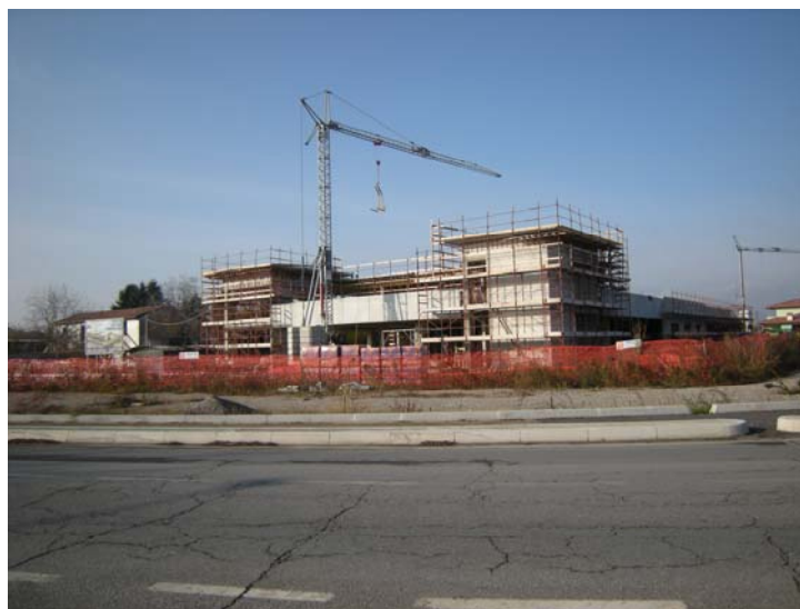
Figura 15 - Stato di fatto della realizzazione del nuovo insediamento commerciale
