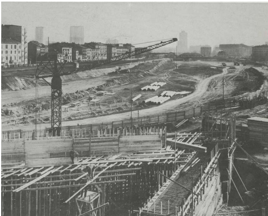
Fig.27 Lavori di sterro per la costruzione della nuova stazione delle linee Varesine e cavalcavia di via Farini (1950)
