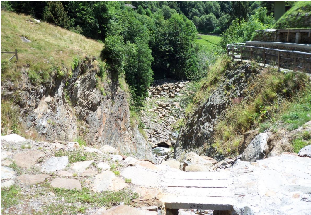
Figura 37: Versante al di sotto del ponticello in cemento
