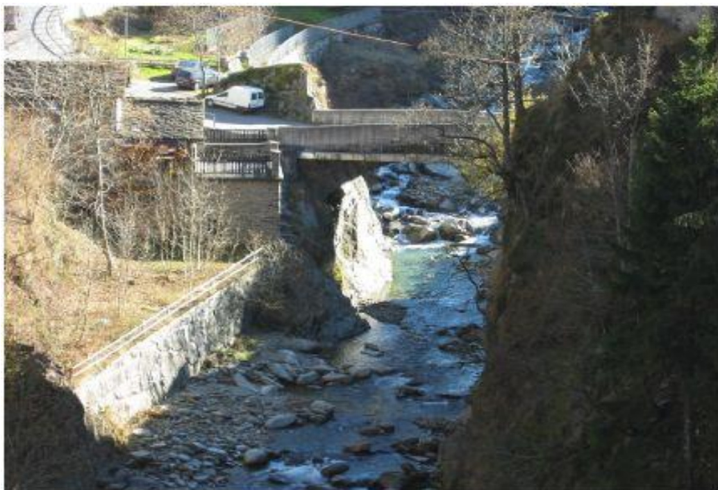
Figura 8: Vista da valle del ponte alla confluenza tra i due Torrenti
