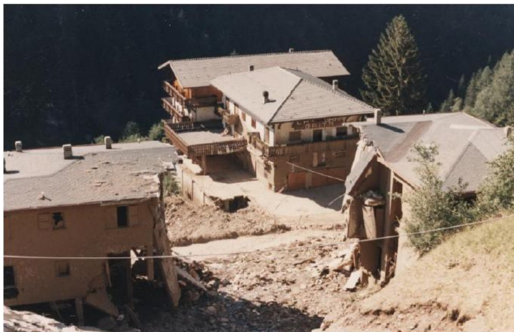
Figura 13: Danni provocati da un debris flow
