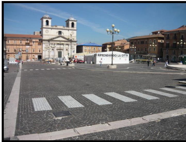
Fig. 82 – Piazza Duomo, centro storico L'Aquila, veduta da via Federico II, giugno 2010
