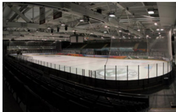
Figura 39: il reticolo di apparecchi sospesi sopra la pista di ghiaccio, in un impianto indoor
