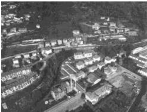
Figura 30: Vista del villaggio Crespi
