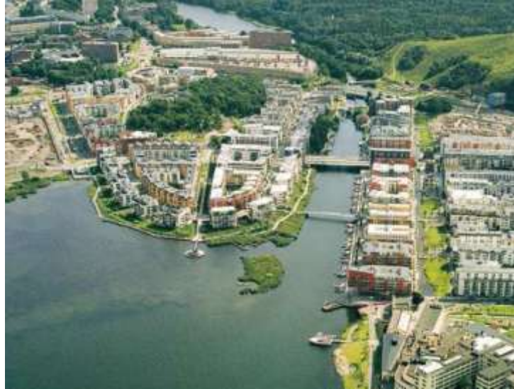
Figura 20: Vista del quartiere situato tra il Lago e il bosco di Sickla
