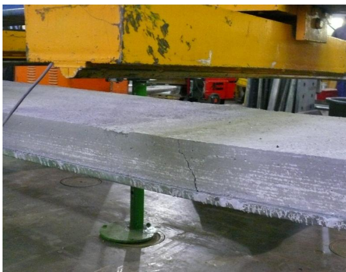
Figura 5.5.2 Fessura diagonale per rottura a flessione
