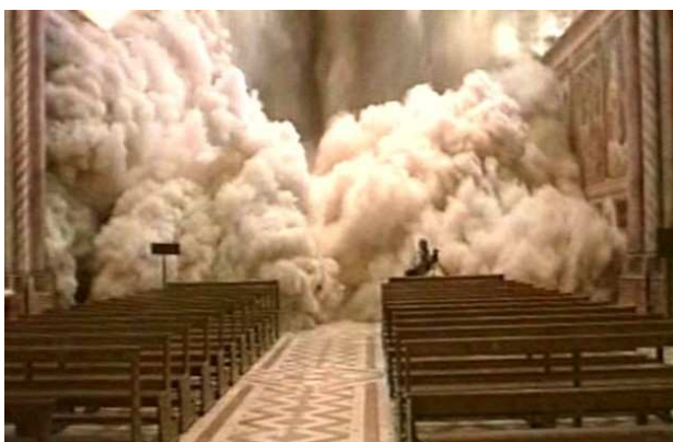
Figura 3.1 – Il crollo della volta nella Basilica superiore di Assisi avvenuto il 26 settembre 1997
