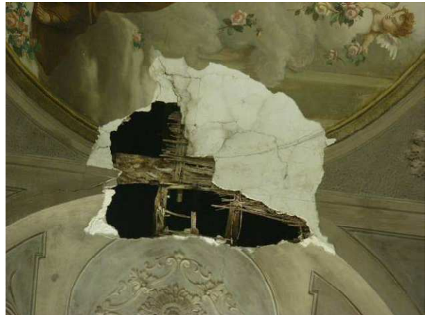
Figura 2.20 - Volta in camorcanna, messa in luce grazie ad una lacuna avvenuta a seguito del sisma
