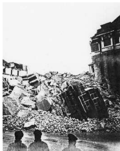
Figura 3.4 – Il crollo della Torre Civica di Pavia.
