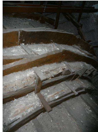
Figura 6.112 – Dettaglio delle centine lignee della volta.
