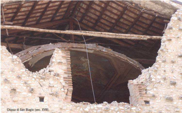
Figura 2.18 - Orditura lignea del tetto della navata centrale di san Biagio
