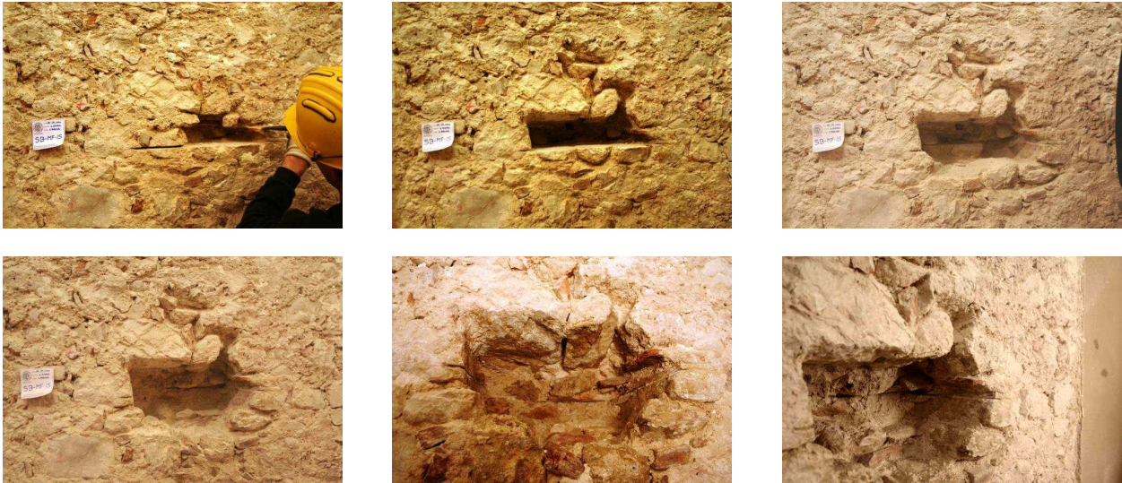
Figura 6.78 - Smontaggio parziale della muratura in corrispondenza del taglio superiore della prova SB-J2D.
