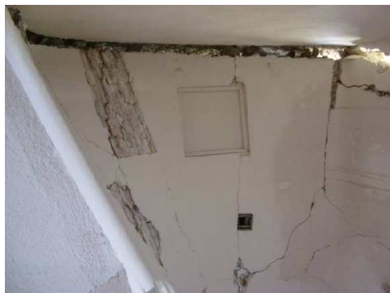
Figura 2.45 – Volta di mattoni al di sopra dell'ambiente d'angolo sud est (vista dal basso).
