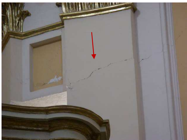
Figura 6.21 – Lesione orizzontale a livello della cantoria.
