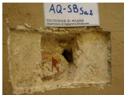
Figura 6.81 - Saggio AQ-SBa2: particolare dei due strati d'intonaco sovrapposti e della pietra.
