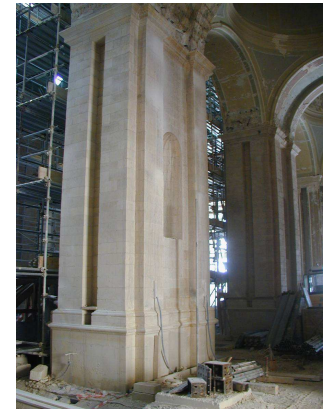
Figura 3.8 – Vedute dei pilastri ricostruiti e dell'innesto con la muratura sovrastante originale (cortesia di Lorenzo Cantini).
