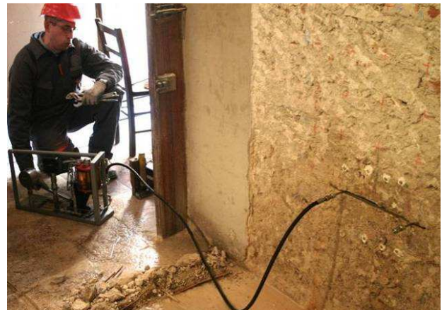
Figura 6.49 - Esecuzione della prova .
