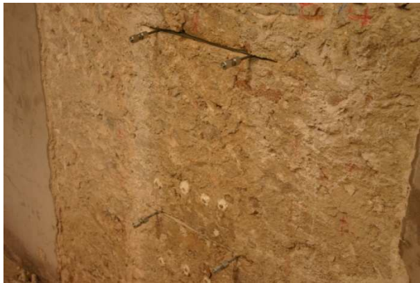
Figura 5.34 – Preparazione del paramento per l'esecuzione della prova a compressione monoassiale.
