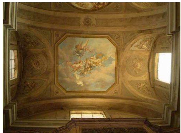
Figura 2.8 – Volta in camorcanna a copertura della prima campata della navata centrale
