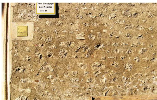
Figura 6.175 – Lato esterno della muratura.
