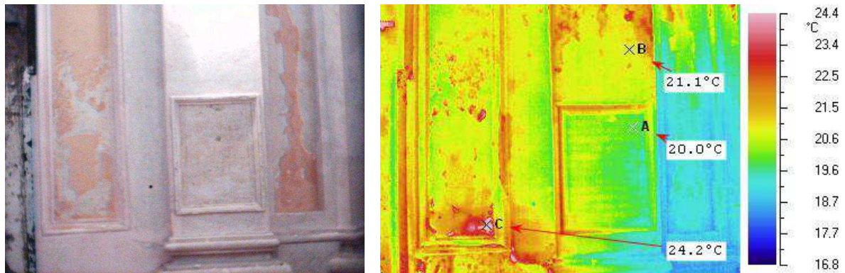
Figura 6.187 – Termografia attiva condotta sulle murature perimetrali OSG-T2.
