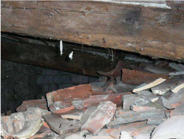
Figura 6.117 – Accumulo di materiale al di sopra della cupola laterale e timpano di chiusura della campata.
