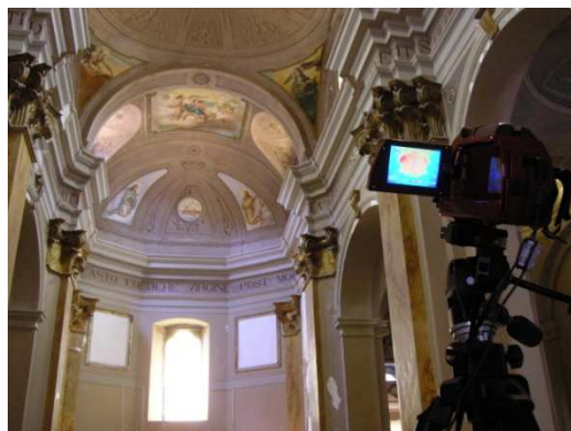
Figura 5.4 - Esecuzione della prova termografica sulla volta in camorcanna.
