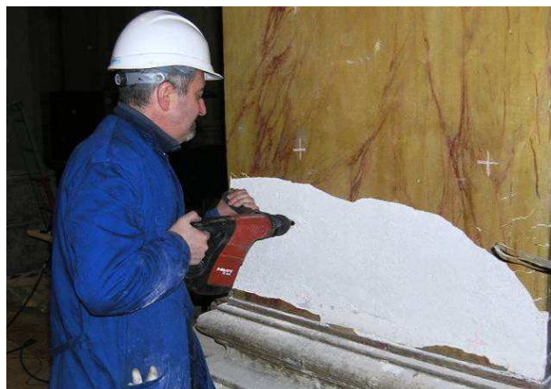
Figura 5.19 – Esecuzione di un foro mediante trapano a percussione.
