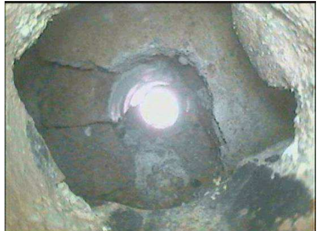
Figura 6.108 – Vista endoscopica in corrispondenza del vuoto nella muratura.
