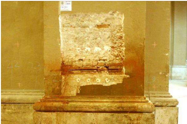
Figura 6.153 – Prova SB-J3S condotta sul pilastro G.
