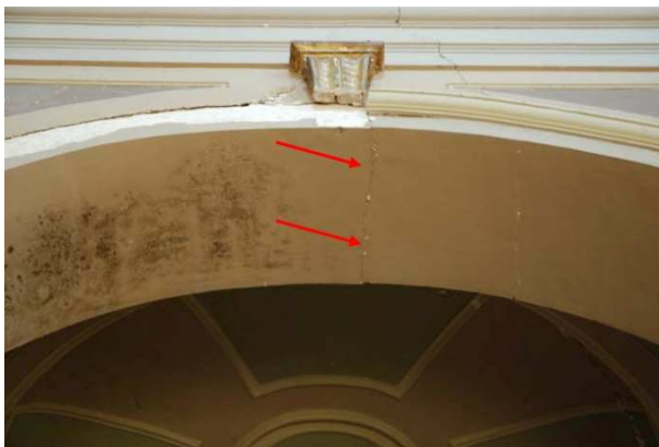
Figura 6.14 – Scorrimento trasversale della prima arcata sul lato sinistro.
