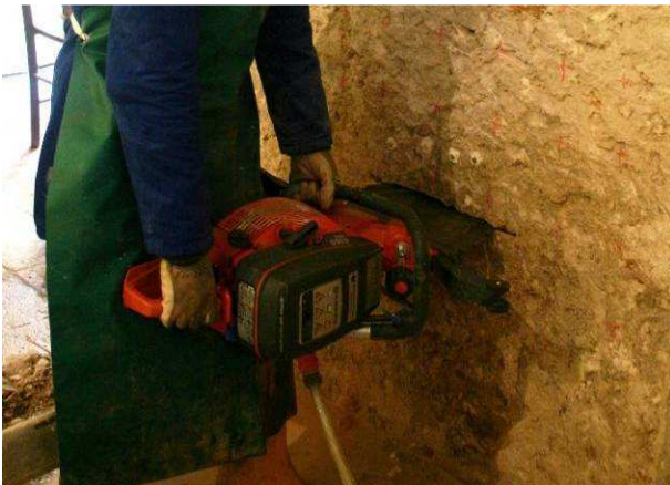
Figura 6.48 - Esecuzione del taglio nella muratura.
