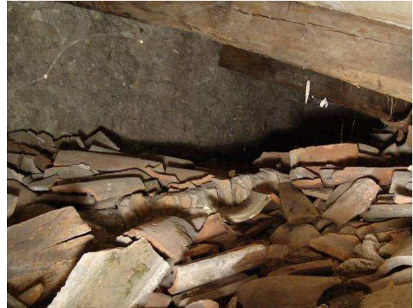
Figura 6.118 – Vista dell'estradosso di una cupola della navata laterale.
