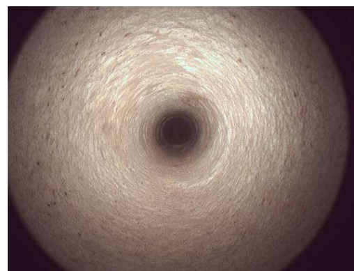
Figura C.5 – Vista endoscopica sulla muratura perimetrale ovest.
