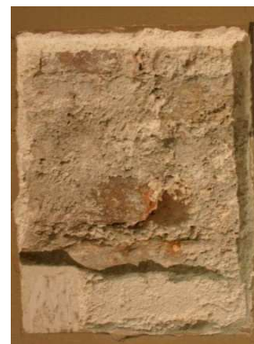
Figura 6.173 – Saggio stratigrafico eseguito sul pilastro H.
