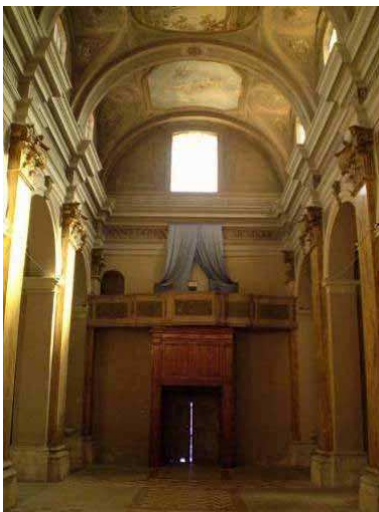
Figura 4.33 – Interno della chiesa di san Biagio prima del crollo.
