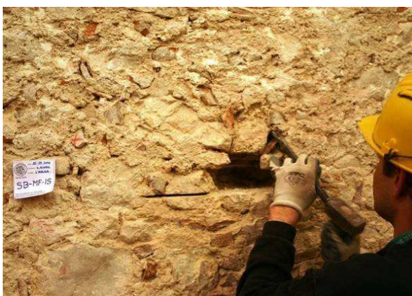
Figura 5.25 – Operazione di smontaggio dell'apparecchio murario in prossimità di un taglio eseguito per prova con martinetto piatto.
