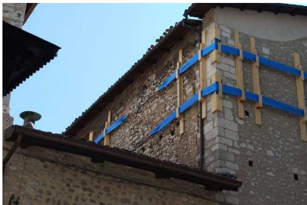
Figura 2.41 – Porzione sommitale di facciata
