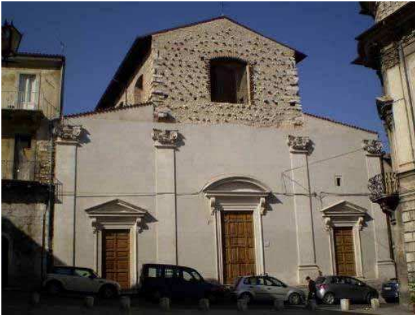
Figura 4.29 – Il fronte di san Biagio prima del crollo
