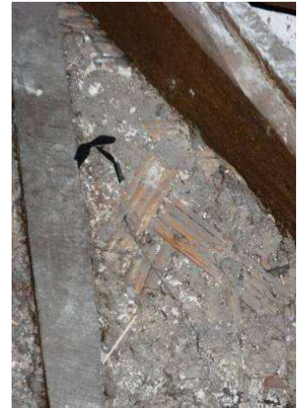
Figura 6.113 – Dettaglio dell'intreccio delle canne.
