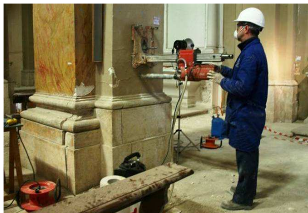
Figura 5.22 – Esecuzione di un carotaggio.
