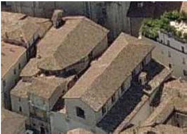
Figura 2.19 - Copertura della chiesa di San Biagio
