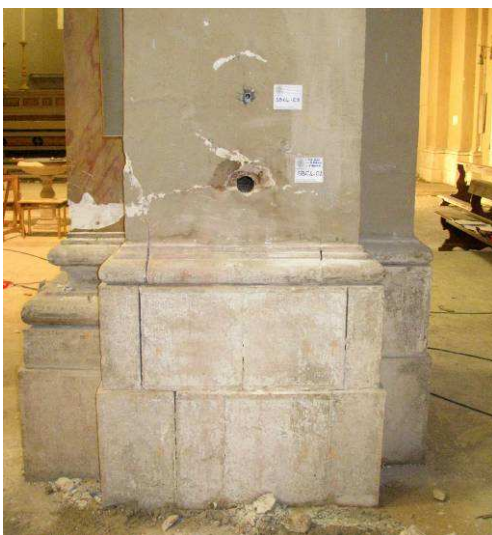
Figura 6.127 e 6.128 – Localizzazione e rappresentazione schematica della stratigrafia osservata con l'esame endoscopico.
