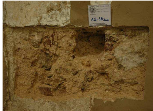
Figura 6.84 – Particolare ammorsamento AQ-SBA8.
