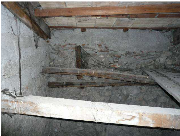
Figura 6.115 e 6.116 – Porzione di muratura in blocchi di cls posti a chiusura della muratura della controfacciata.
