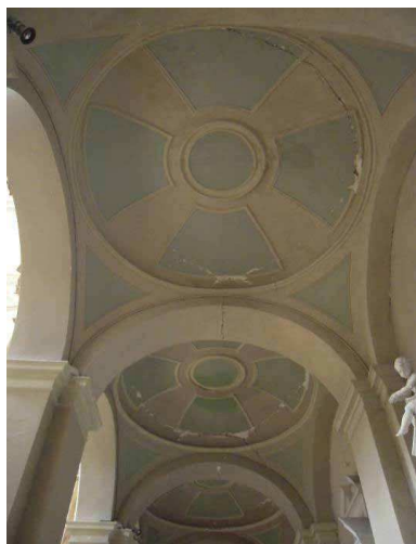
Figura 4.52 – Lesioni nelle cupolette della navata laterale di destra, viste verso la facciata.
