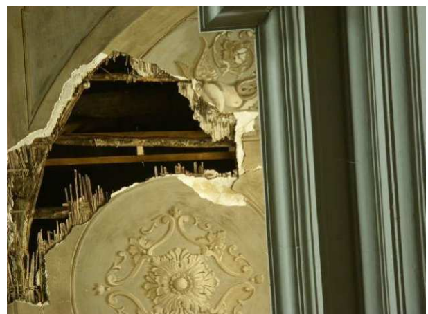
Figura 2.17 - Volta in camorcanna in corrispondenza di una lacuna
