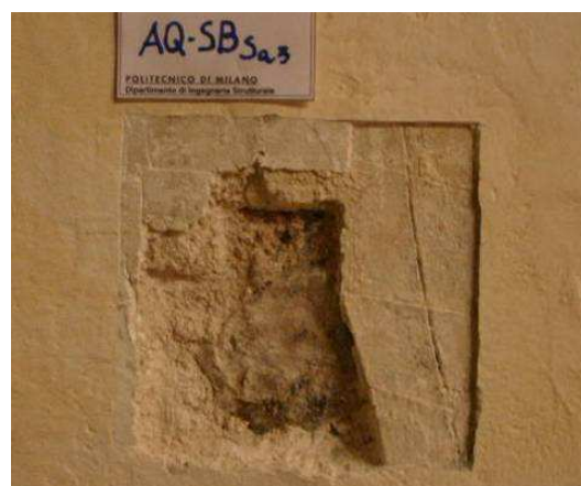
Figura 6.82 - Saggio AQ-SBa3: particolare dei due strati d'intonaco sovrapposti e della pietra.
