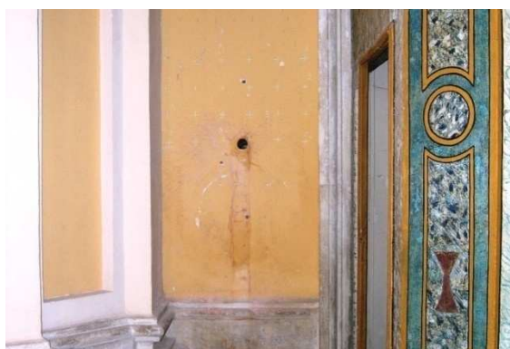
Figura 6.176 – Lato interno della muratura.
