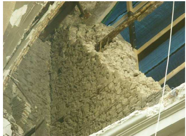
Figura 2.15 - Muratura della porzione sommitale della facciata
