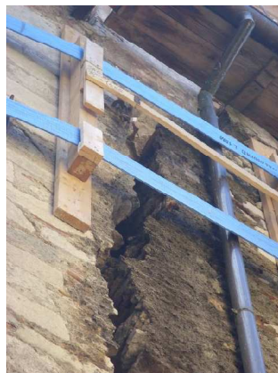
Figura 2.42 – Ammorsamento in angolo fra via Roio e via degli Scardassieri, vista esterna.
