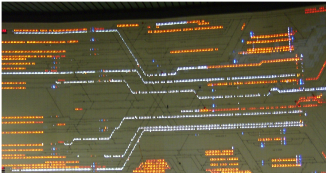
Figura 2.9 Il QL delle Cabina ACEI di Milano Centrale. Si possono distinguere contemporaneamente gl'itinerari di arrivo linea Malpensa, arrivo linea Chiasso, partenza linea Venezia, partenza linea Bologna, arrivo e partenza linea Genova, e due movimenti di manovra. Le strisce rosse rappresentano i binari occupati da materiale rotabile mentre le strisce bianche gl'itinerari riservati ai movimenti dei treni
