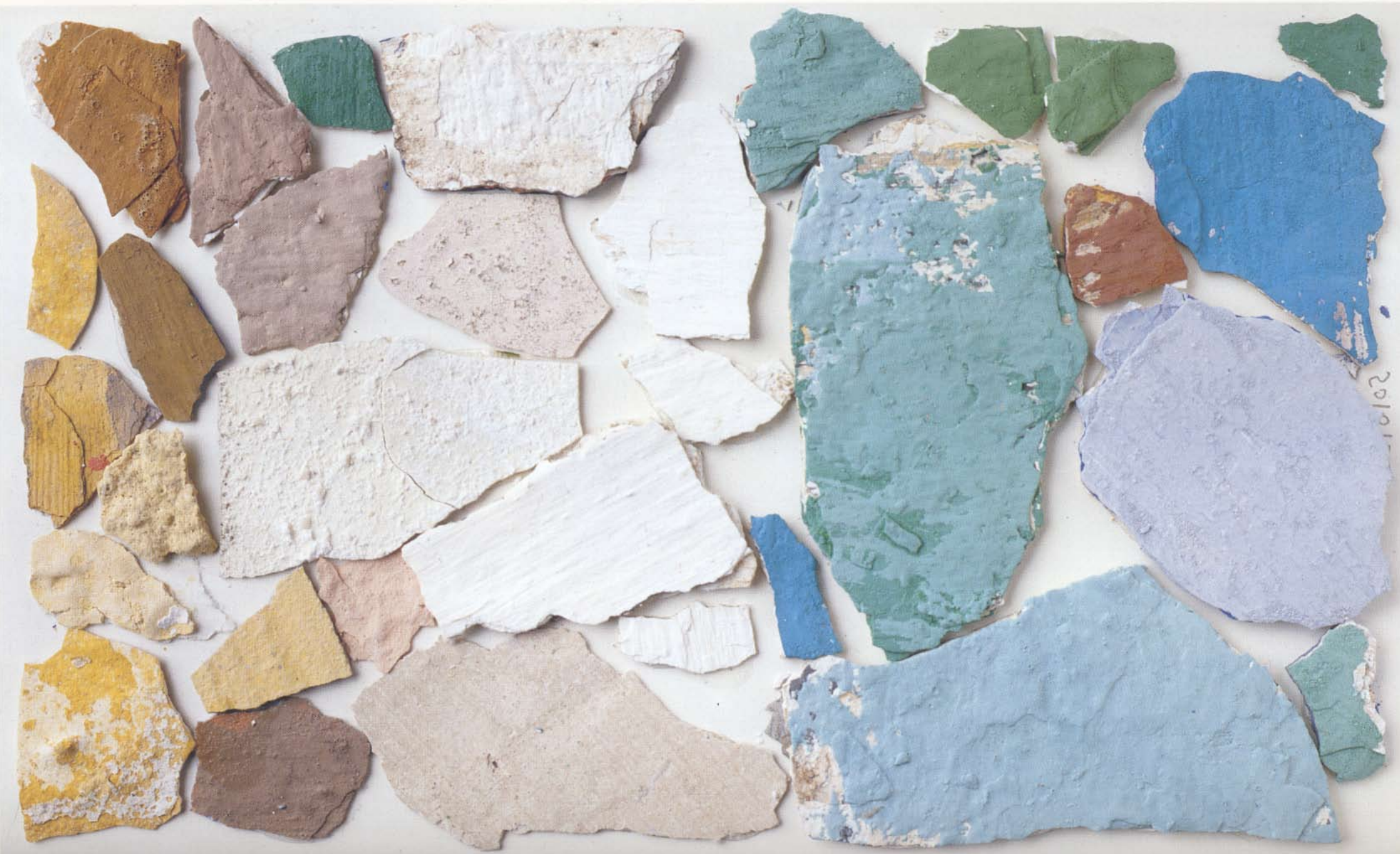
Intonaco segnato dal tempo
