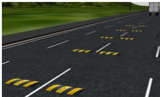
Figura 8.20. Disposizione dei riduttori di velocità.
