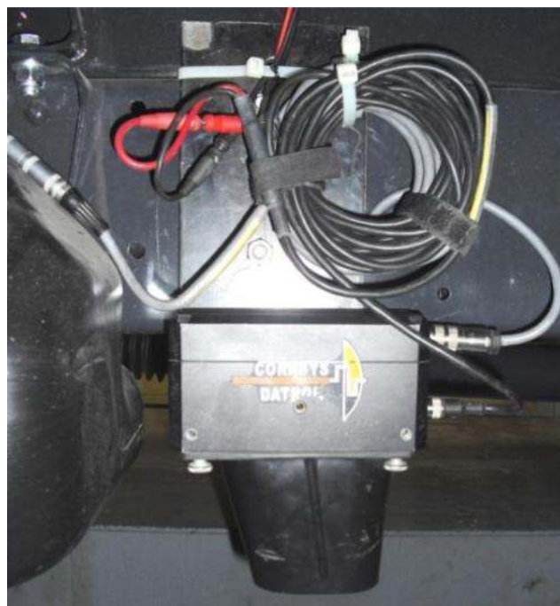
Figura 9.9. Installazione del sensore di velocità longitudinale.
