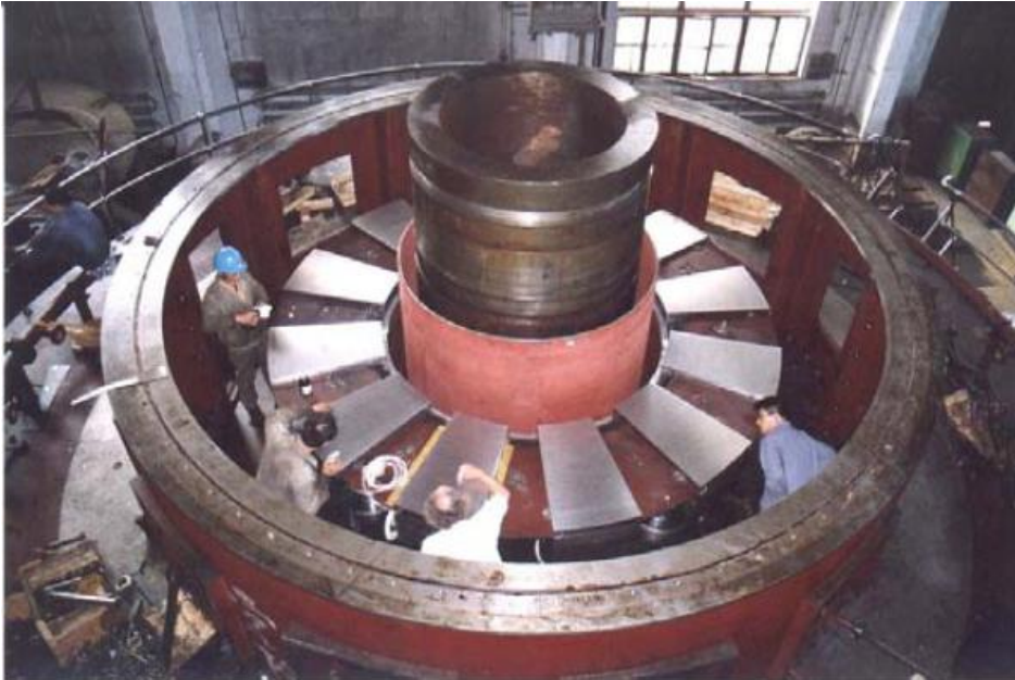
Figura 1.2. Operai al lavoro per la realizzazione di un cuscinetto assiale con capacità di carico di 3000 tonnellate [2].
