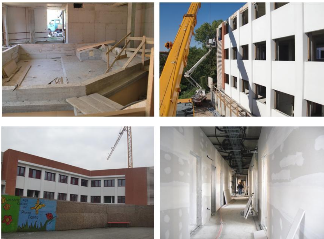
Figura 6.10 – Alcune foto del cantiere in corso.
