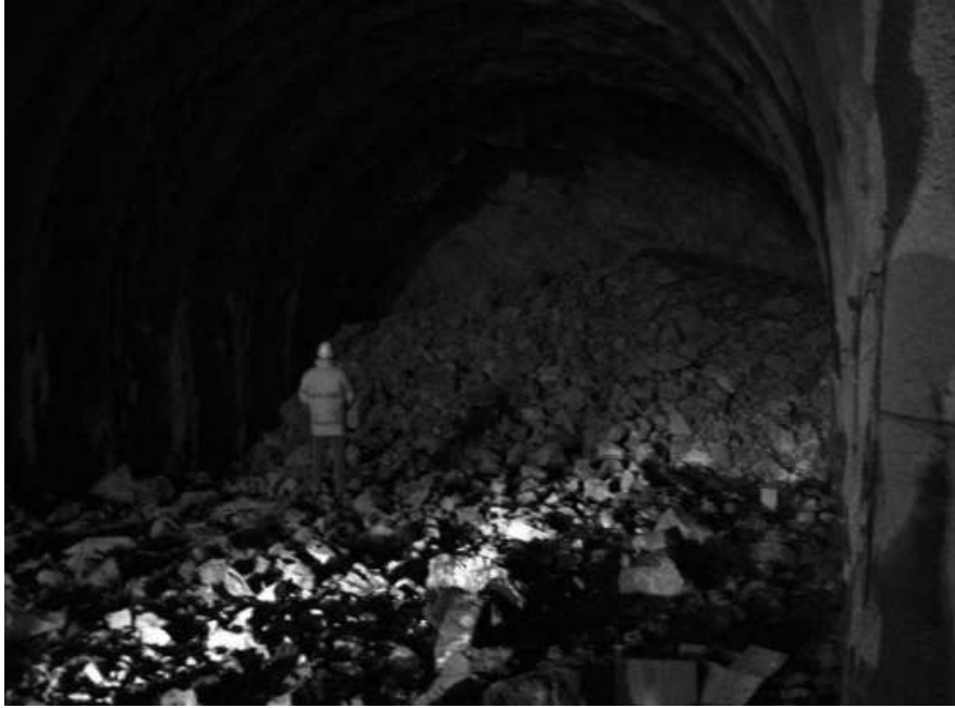
Figura 4.9- Fronte di scavo dopo il brillamento della quinta volata di prova.
