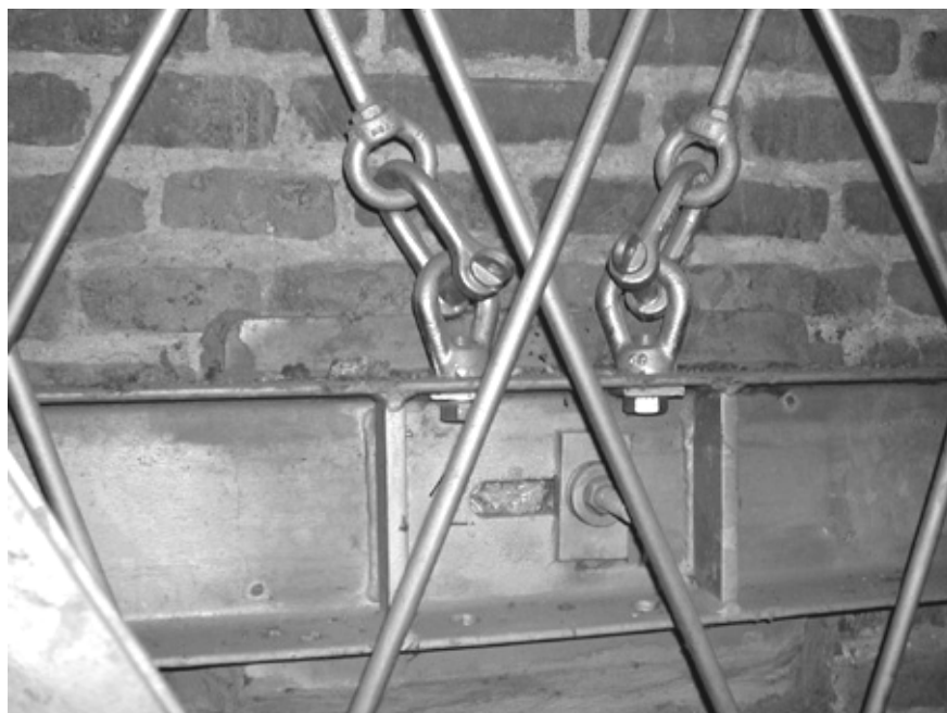
Figura 23 Girello metallico interno alla torre muraria [19]
