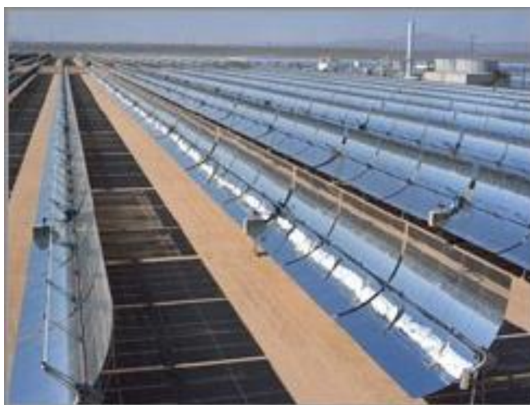
Figura 0.4: Solare termodinamico. Specchi parabolici vengono disposti in righe per massimizzare l'accumulo di energia solare nel minimo spazio possibile.
