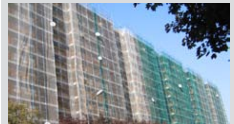
136. ristrutturazione edifici in linea
