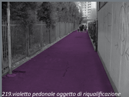
219. vialetto pedonale oggetto di riqualificazione
