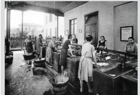
50.lavatoi quartiere Ripamonti
