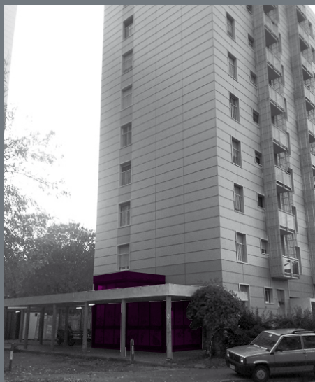
212.residenza riqualificata e portineria dismessa
