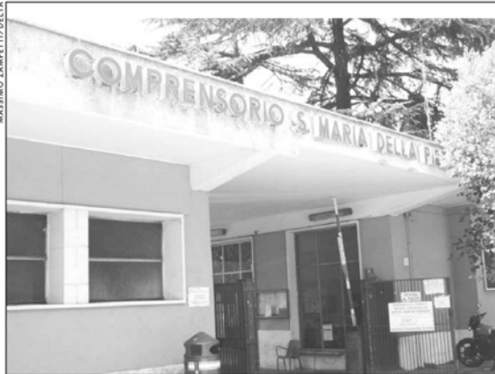
Ecco come si presenta oggi l'ingresso dell'ex manicomio di Roma.
