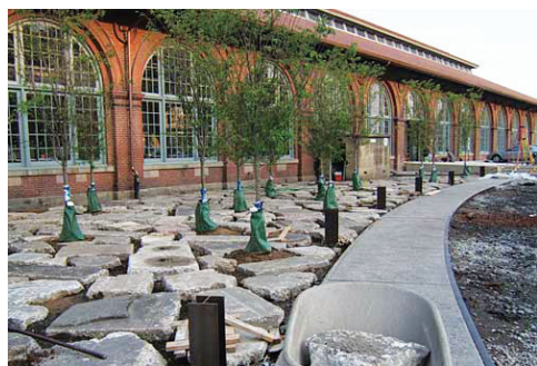
(fig.9) Urban Outfitters, vista di cantiere.
