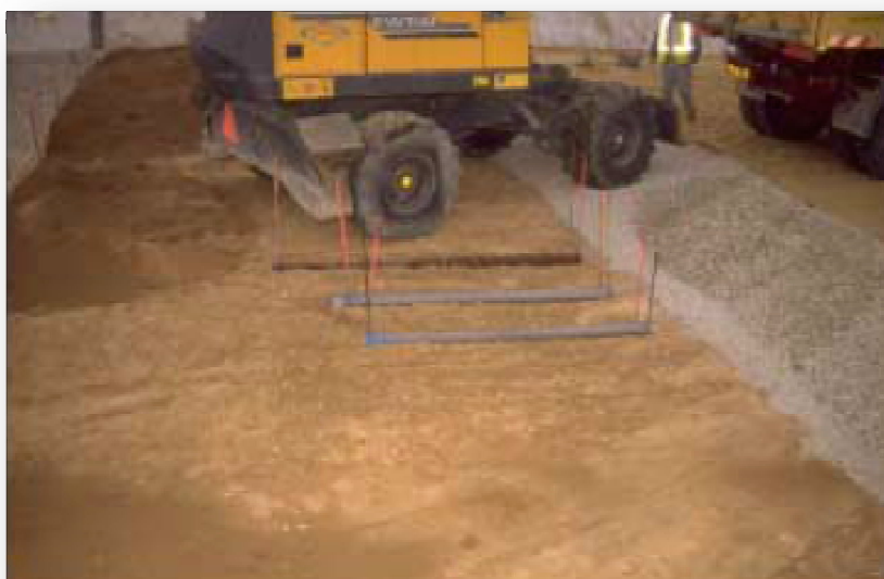
Figura 2.3 - Posa degli stendimenti di tubi nella zona 1
