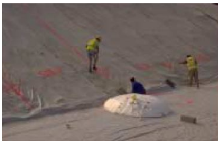
Figura 2.14 - Lavori di posa degli strati geotessili sul fianco della vasca
