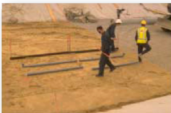
Figura 2.7 - Posa degli stendimenti di tubi nella zona 3
