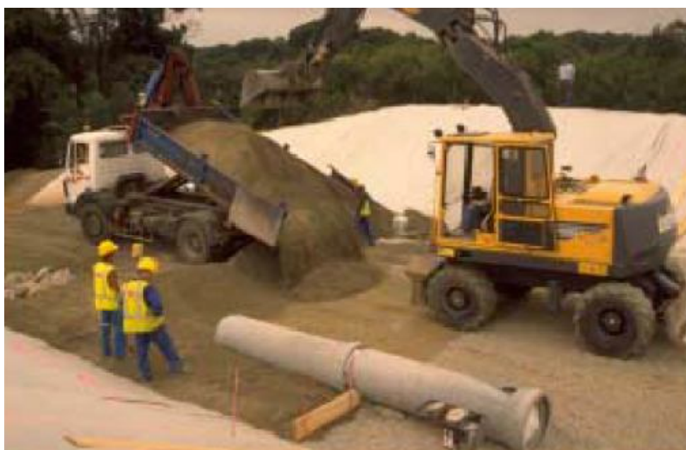
Figura 2.15 - Lavori di riempimento dello scavo tramite l'utilizzo di un automezzo con benna
