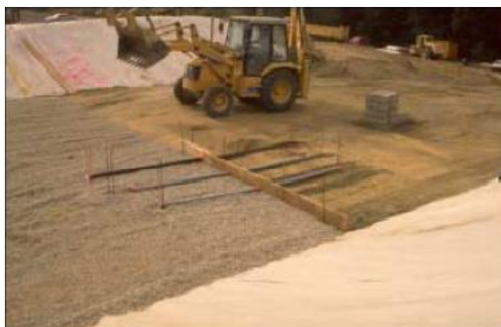
Figura 2.12 - Posa degli stendimenti di tubi nella zona 5
