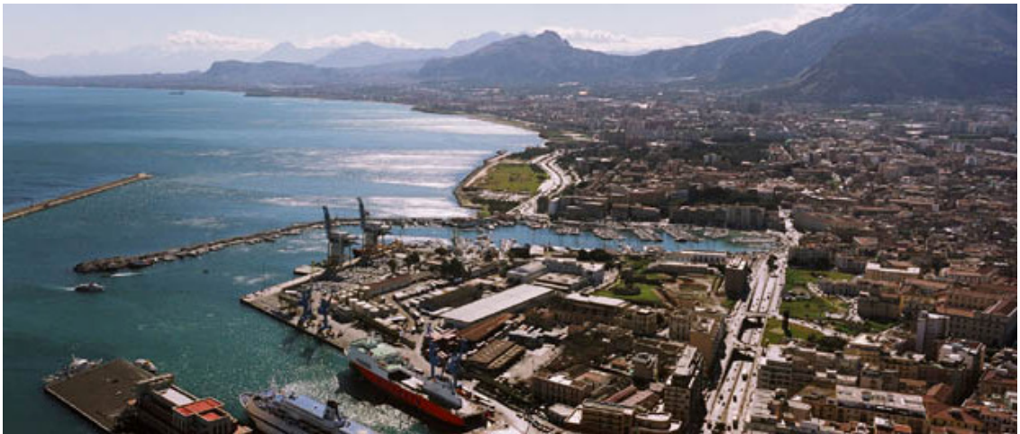
Figura 1 – Vista della Cala e dell'area delle rovine del Castello a Mare
