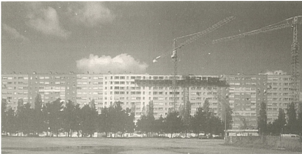
Figura 5 - Quartiere residenziale Quai de Rohan prima dell'intervento
