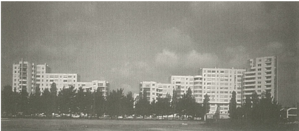
Figura 6 - Quartiere residenziale Quai de Rohan dopo l'intervento
