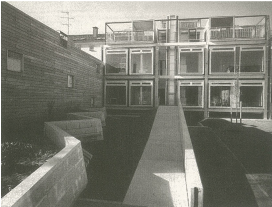
Figura 8 - Uffici a Rathenow dopo l'intervento di recupero
