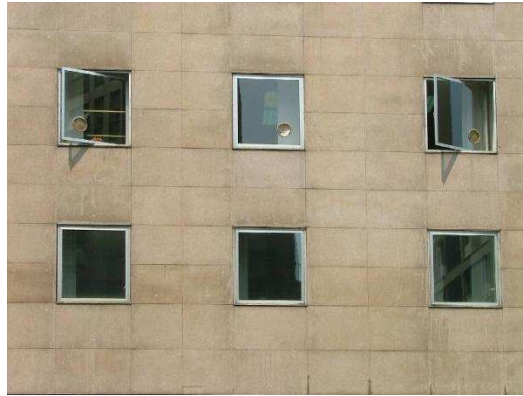
Fig. 26 Particolare della facciata., edificio per abitazioni e uffici.
