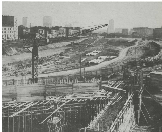
Fig.32 Lavori di sterro per la costruzione della nuova stazione delle linee Varesine e cavalcavia di via Farini (1950)
