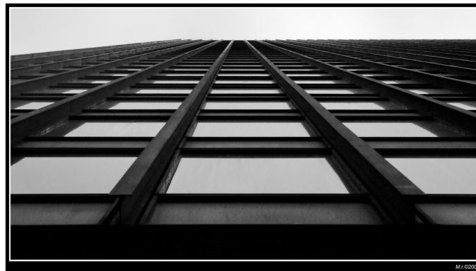
Fig. 23 Particolare della facciata, Segram Building
