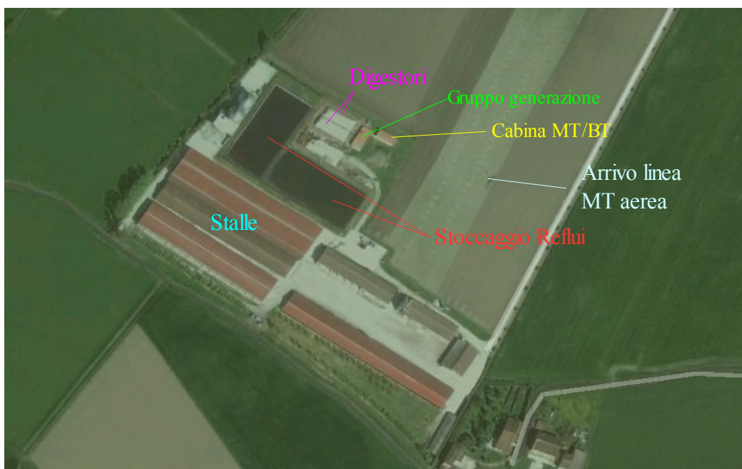
Figura 4.12 - Vista dall'alto dell'impianto biogas
