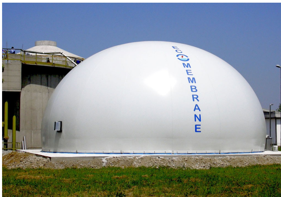
Figura 3.1 - Gasometro in funzione
