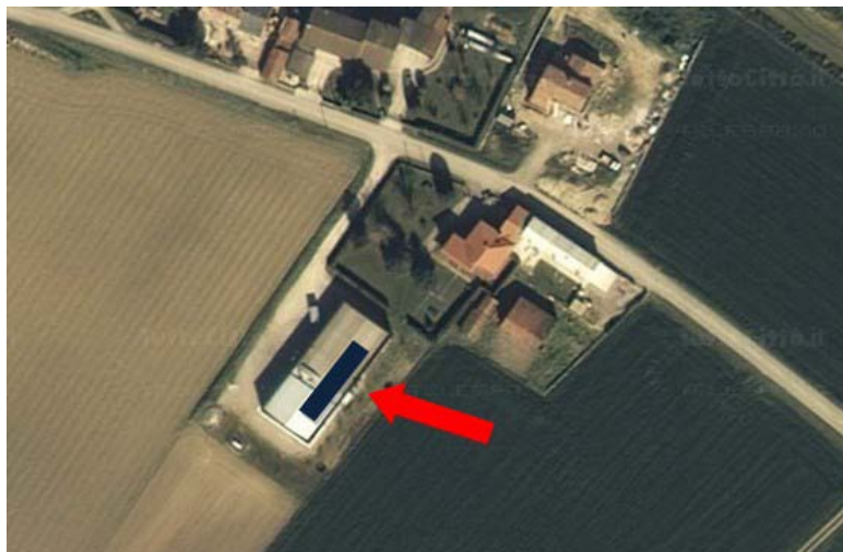
Figura 4.9 - Vista dall'alto dell'impianto fotovoltaico da 15,38 kWp
