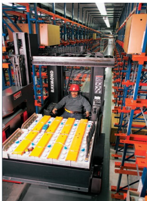
Figura 3.6 - Fase di installazione di una delle 13.760 batterie SAFT dell'Alaskan BESS di ABB
