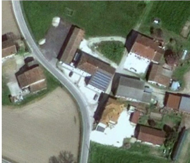
Figura 4.3 - Vista dall'alto dell'impianto fotovoltaico da 13,65kWp
