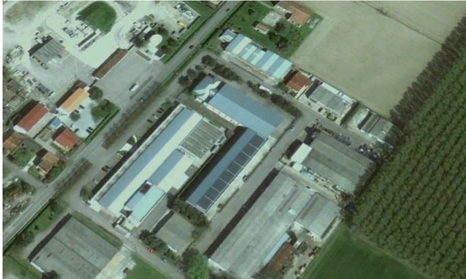
Figura 4.6 - Vista dall'alto dell'impianto fotovoltaico da 64,8 kWp
