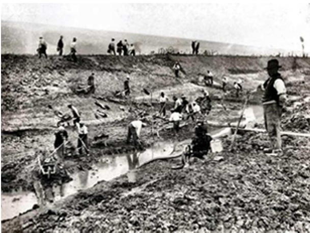
Fig.66. Estrazione manuale dell'argilla
