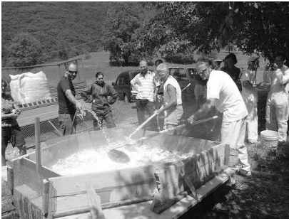
Fig.31. Fase di spegnimento calce viva
