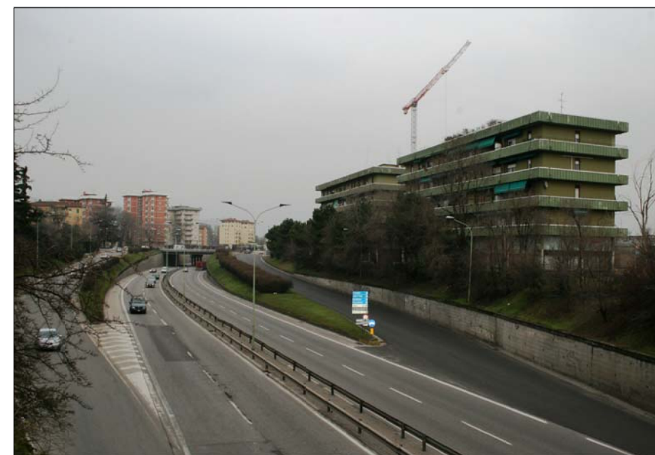
Fig. 18 : vista della tangenziale Ovest dal ponte di attraversamento Sud
