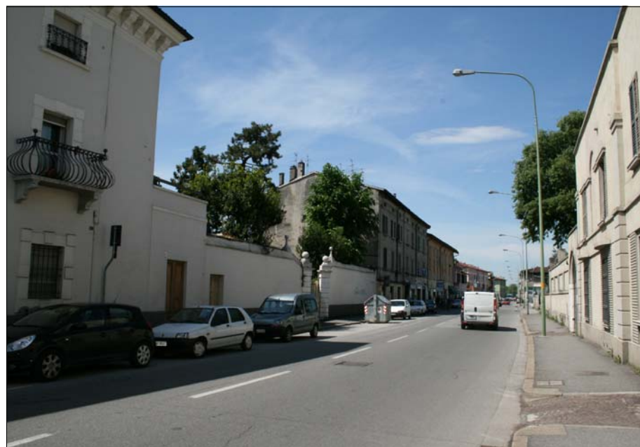
Fig. 11: vista della parte Ovest del fronte di intervento di via Milano
