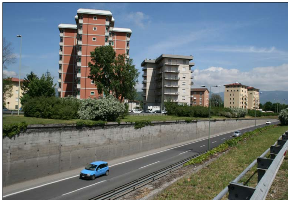
Fig. 19: vista dell'area ad Ovest della tangenziale
