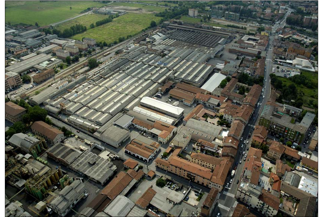
Fig. 32: vista aerea della parte Ovest dell'area di progetto
