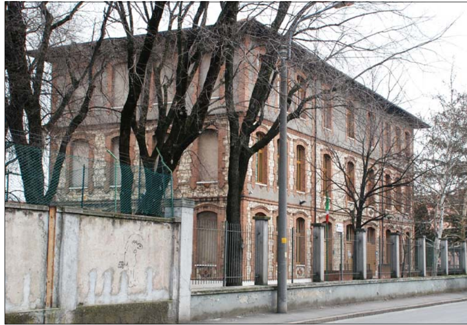
Fig. 25: edificio storico che ospita la circoscrizione Ovest del Comune di Brescia, l'ambulatorio infermieristico ASL D.G.D.1 e Club Alpino Italiano
