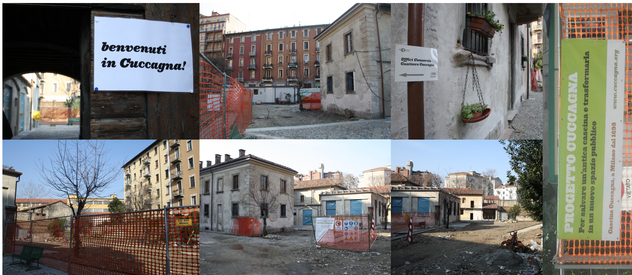
07. Viste della Cascina Cuccagna, stato attuale dei lavori di ristrutturazione, via Cuccagna 2/4, Milano, 2011
