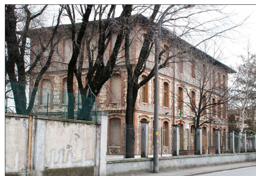
Fig. 12: edificio che ospita la circoscrizione Ovest del Comune di Brescia, l'ambulatorio infermieristico ASL D.G.D.1 e il Club Alpino Italiano
