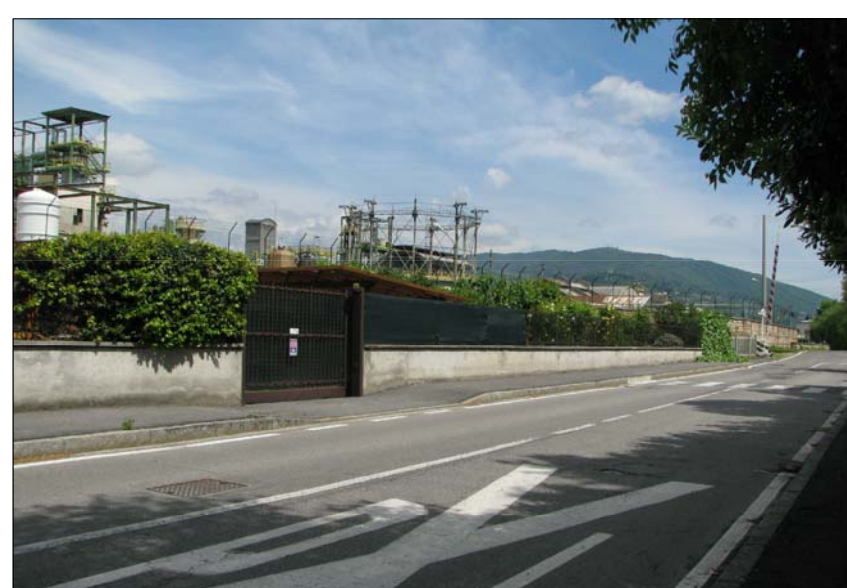
Fig. 14: vista da via Emilio Morosini del confine Sud - Est dell'area
