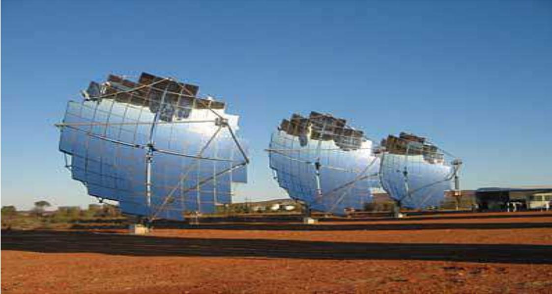
**Figura 3.6:** concentratori fotovoltaici dense array
