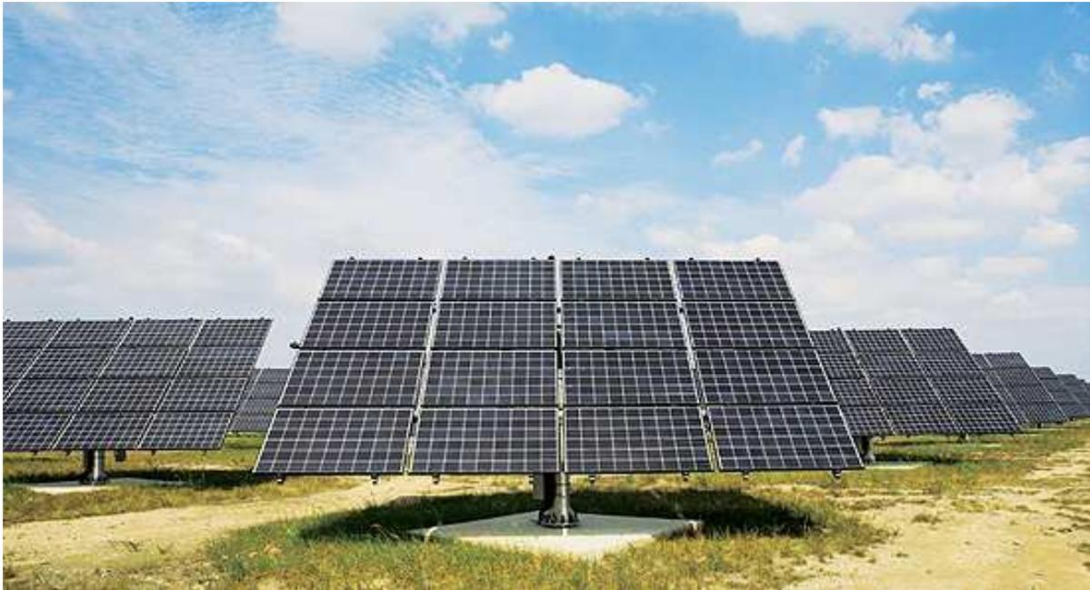
**Figura 3.8:** Esempio di inseguitore
